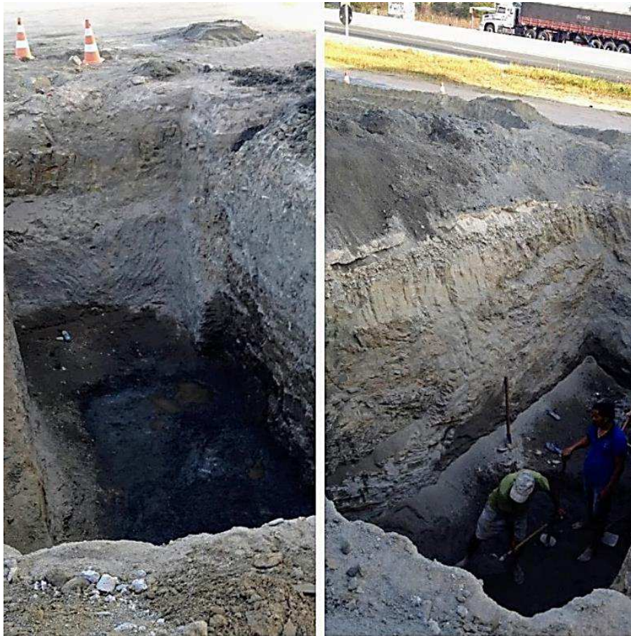
Figura 13 – Processo de escavação para substituição dos tanques. (Imagens cedidas pela administração do posto).
