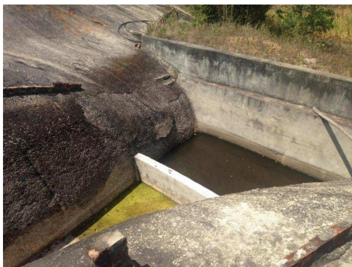
FIGURA 5 - Tanque sobre pedra (2)
