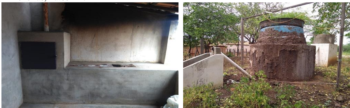
Figura 6 – Tecnologias sociais do fogão ecológico e biodigestor identificadas no Sítio Trincheiras, Patos-PB.
