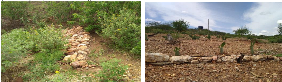
Figura 5 – Utilização de técnicas com barramentos de pedra e recomposição da vegetação para recuperação de áreas degradadas.
