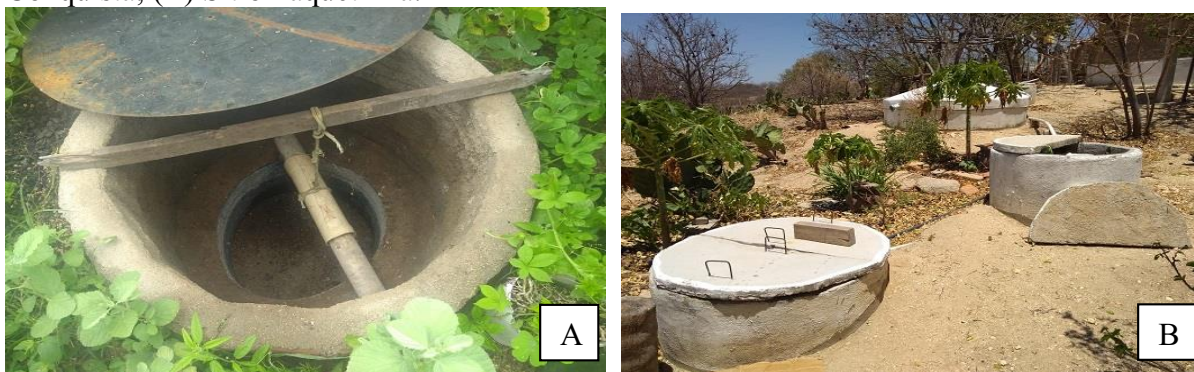
Figura 4 – Filtros biológicos utilizados para reuso das águas cinzas: (A) Sítio Nova Conquista; (B) Sítio Paquetinha.
