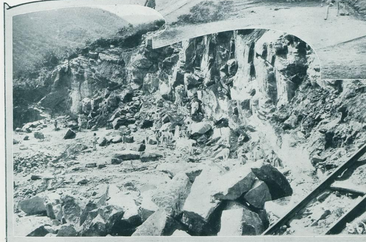
Exploração da pedreira para as obras.
