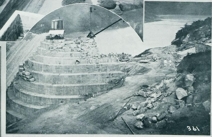
Açude Acarapé. Vista da barragem em con- strução, hombra esquerda.
