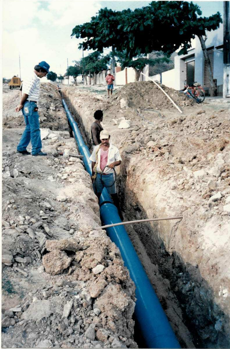
Foto 03 - Colocação da Borracha em um dos Tubos.
