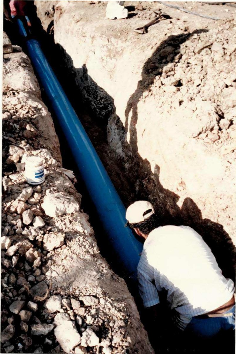
Foto 04 - Encaixe dos Tubos
