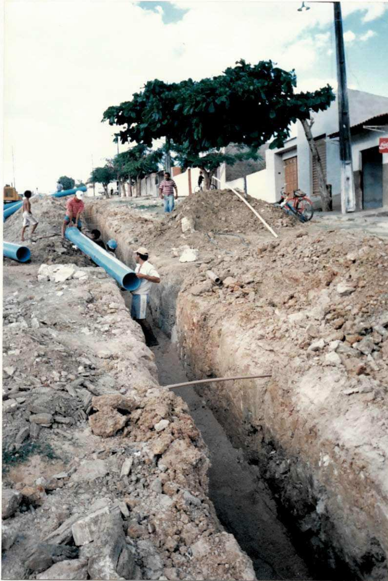
Foto 02 - Colocação dos Tubos.
