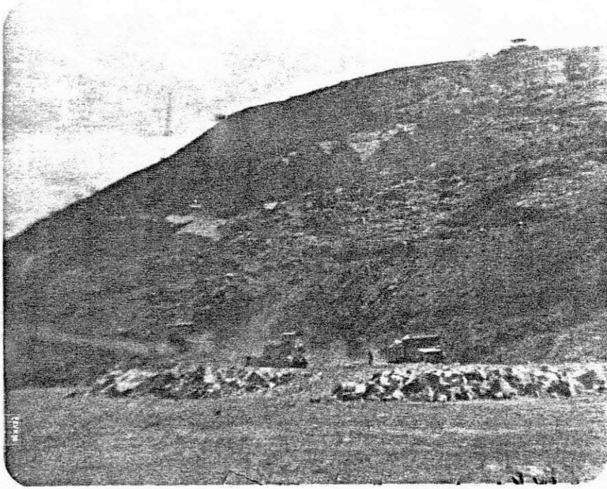
Barragem de enrocamento e desemboque.
