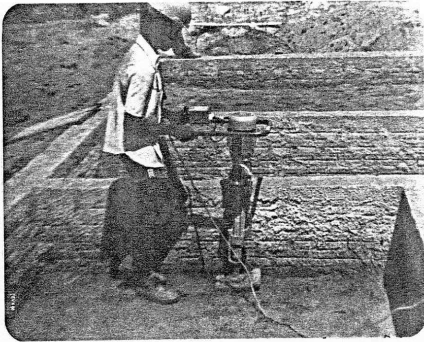
Compactação de aterro de caixão (Alojamentos).
