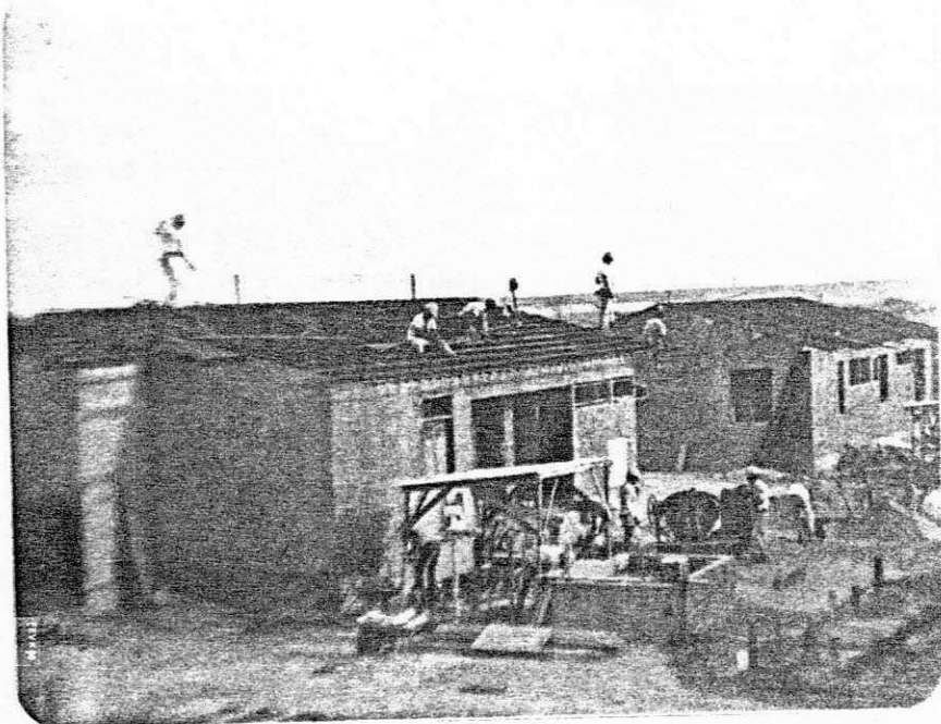
Colocação de coberturas (Vila permanente).
