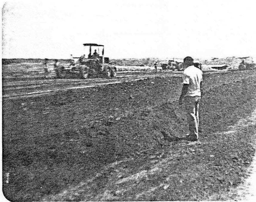
Homogenização e escarificação de solos (Vila temporária)
