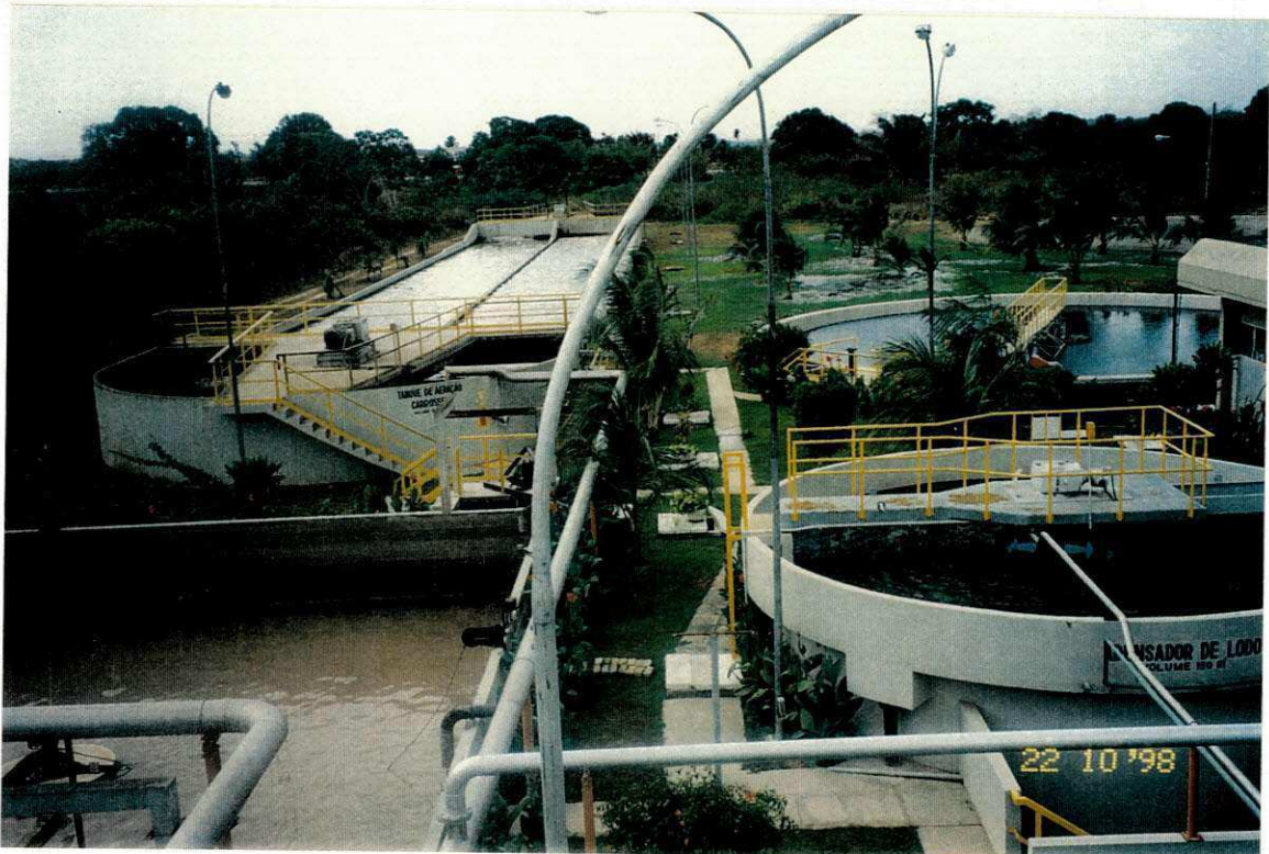
Fig. 06 - Vista Parcial da Estação
