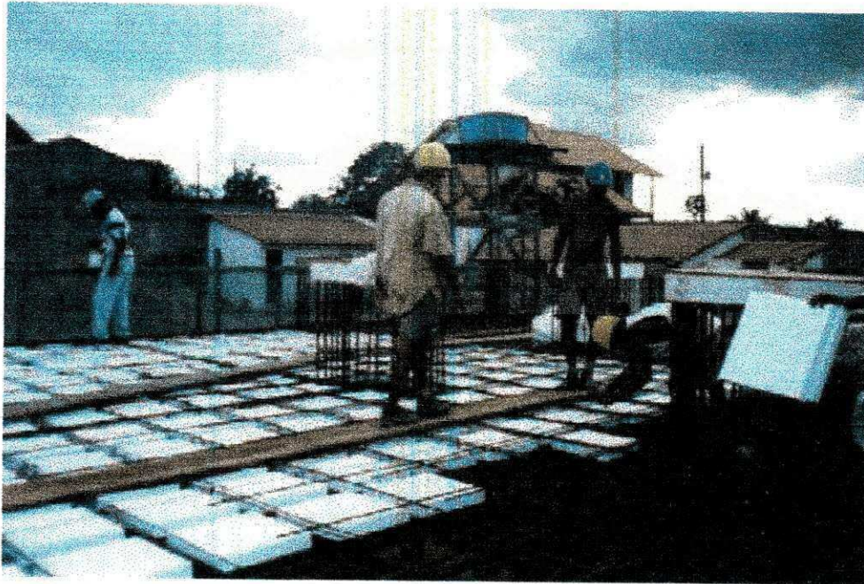
Foto 5 – Laje nervurada moldada no local com utilização de blocos de EPS
