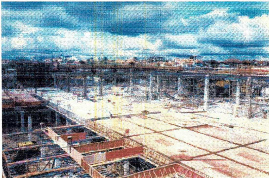
Figura 1 – Vista parcial do serviço de execução de formas das lajes
