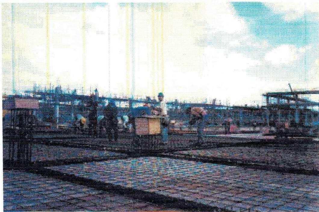
Figura 5 – Execução do serviço de ferragem.
