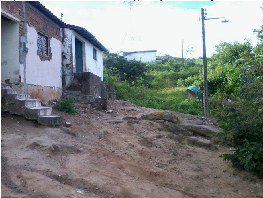
Figura 18 - Solo sem cobertura vegetal apresentando processos erosivos
