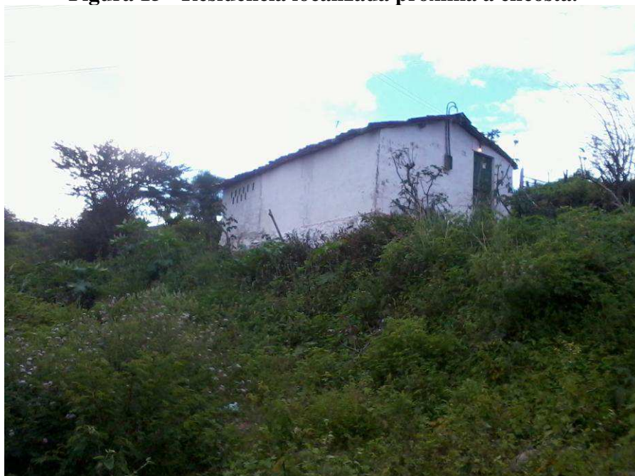
Figura 15 - Residência localizada próxima à encosta.
