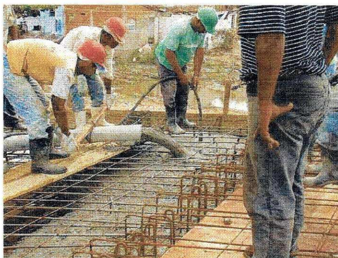
Figura 2.13 - Panorama da concretagem de pontes.
