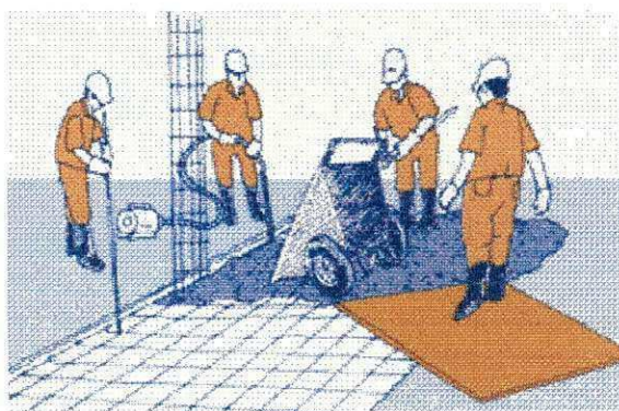
FIGURA 2.5 – Transporte de concreto através de carrinhos de mão.
