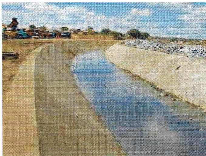
Figura IV.1 – Panorama do primeiro trecho de concretagem finalizado.
