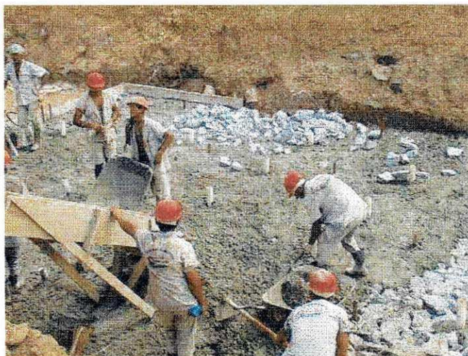
Figura 2.10 - Panorama da concretagem de piso.
