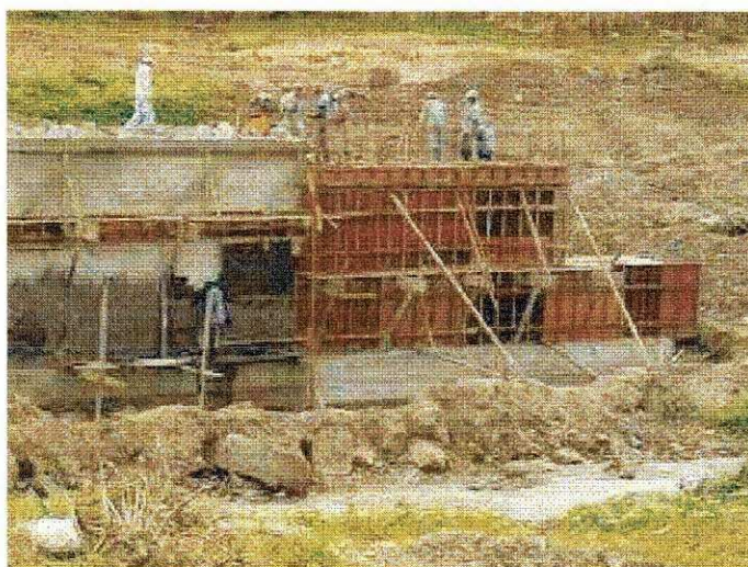
Figura 2.12 - Panorama da concretagem de parede vertical.
