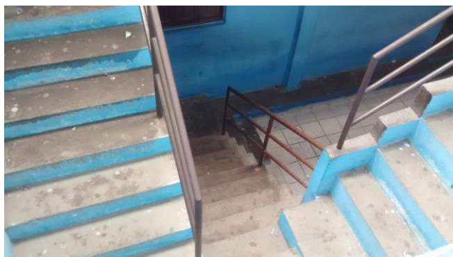
MOURA, 2014 – E.M.E.F. Jardirene Oliveira de Souza – Escadas que dão acesso a outras salas de aulas, compreendendo 3(três) andares.
