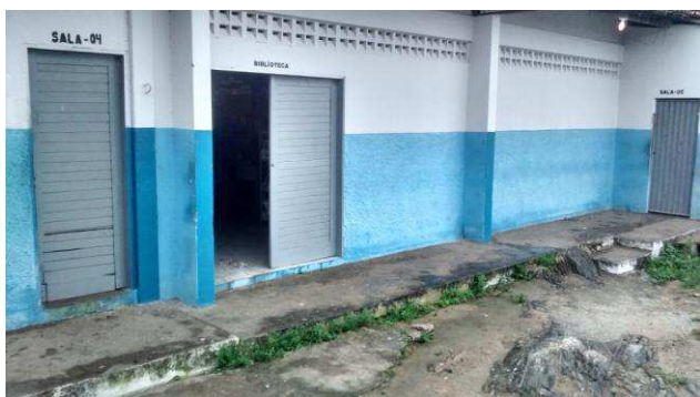
MOURA, 2014 – E.E.E.F.M. Dep. Carlos Pessoa Filho – Salas de aula e biblioteca.
