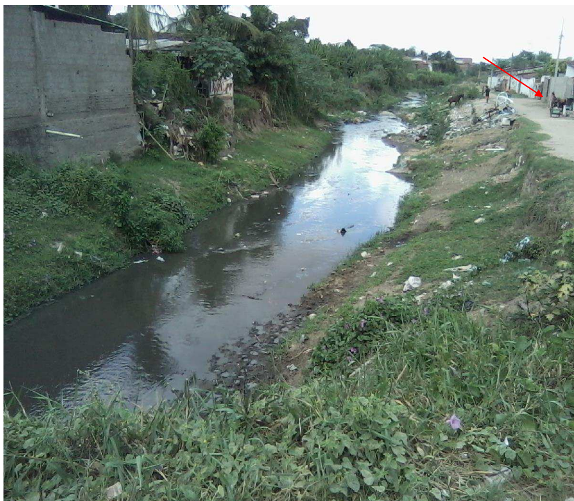
Fotografia 2: Canal 1 - Esgoto a céu aberto (2) Fonte: Data das fotos: 24/04/2014. Fotos: Alessandro B. da Silva
