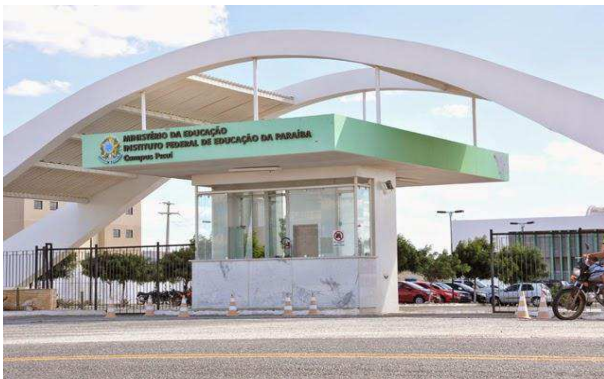
Portão de entrada do campus do IFPB na cidade de Picuí-PB. Fonte: Nogueira, 2015.
