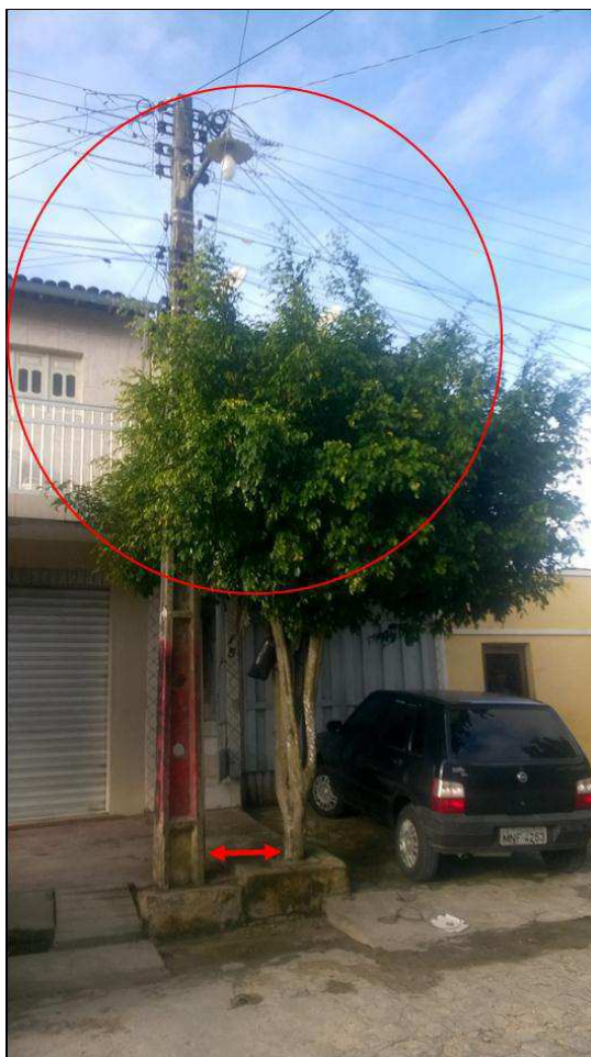
Figura 11 – Indivíduo arbóreo apresentando conflitos com edificações, fiação elétrica e poste de luz
