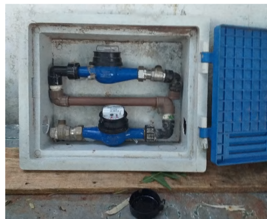
(B) – Modelo onde o medido ficou inclinado
