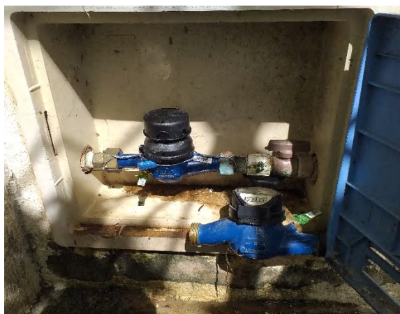
(C) – Substituição concluída
