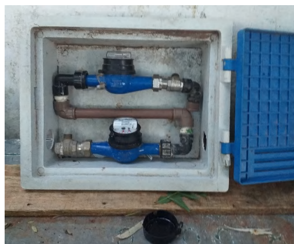
(B) – Modelo onde o medidor ficou inclinado
