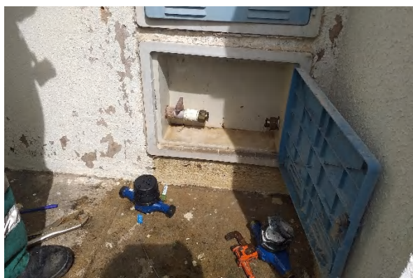
(B) – Execução da substituição
