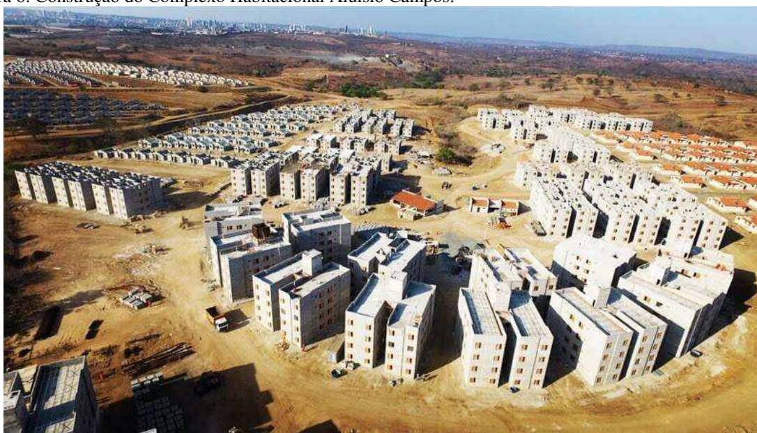
Figura 6: Construção do Complexo Habitacional Aluizio Campos.
