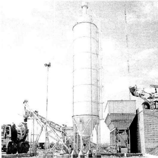
Central de Concreto –
