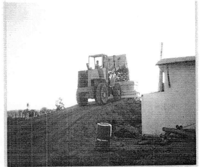
Colocação do Agregado no Silo de Agregado
