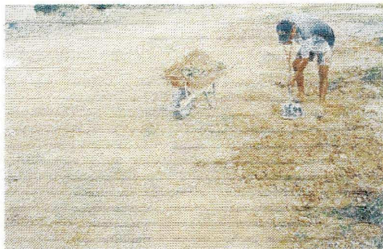
Figura 5.1 - Limpeza do terreno.
