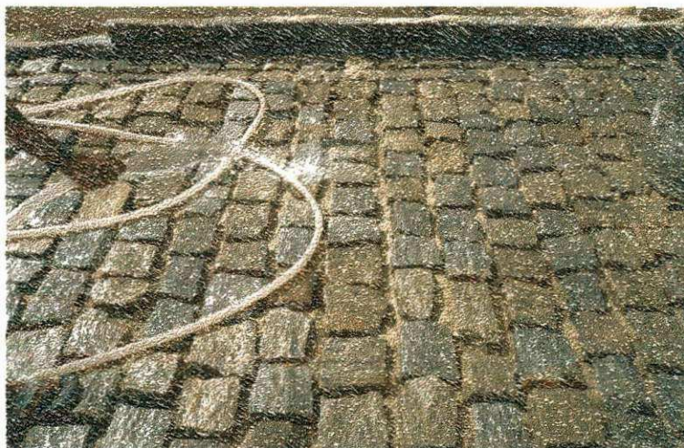
Figura5.6- Adensamento da areia.
