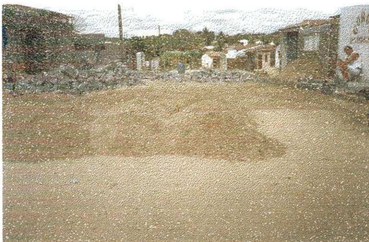
Figura 5.3- Preparação do colchão de areia
