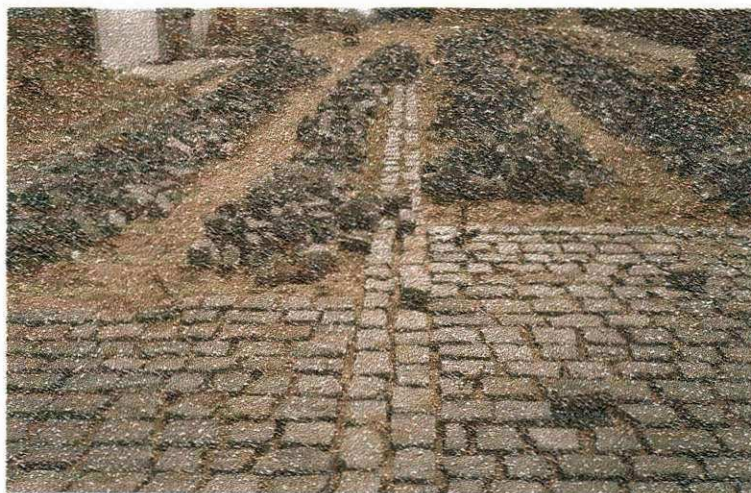
Figura 5.4- Assentamento das pedras sobre o colchão de areia.
