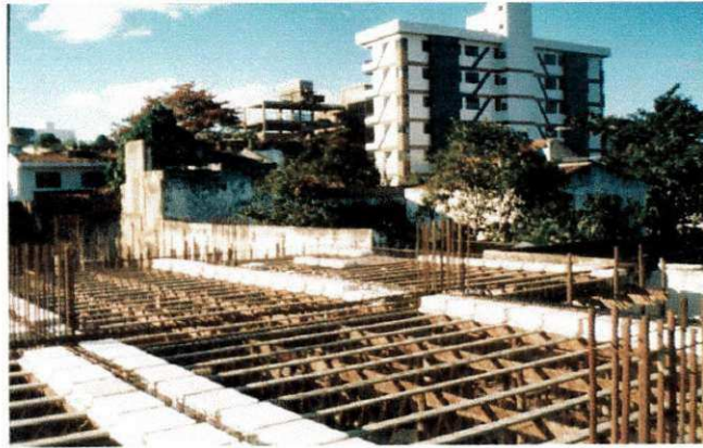
figura 15 a – detalhe das treliças e blocos
