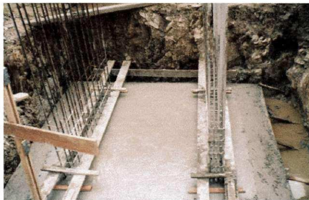
figura 13 – sapata associada, após a concretagem Fonte: pesquisa direta (2003)
