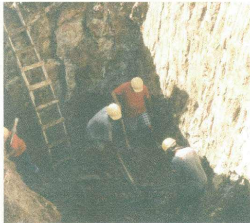
Figura 10 – escavações manuais Fonte: pesquisa direta (2003)
