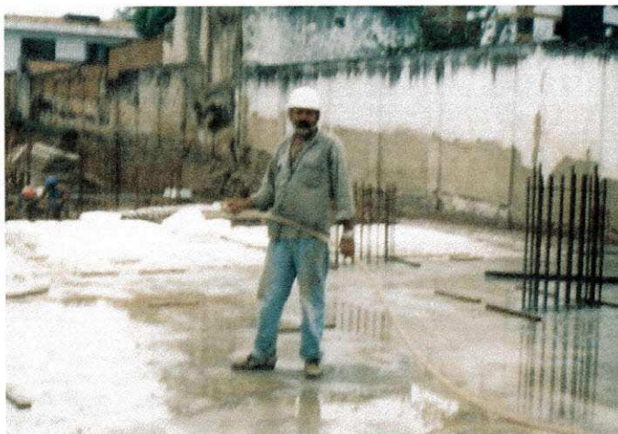
figura 24 – cura das lajes
