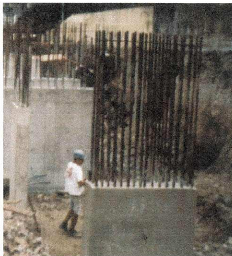
figura 19 - espera de ferragens para emenda por transpasse
