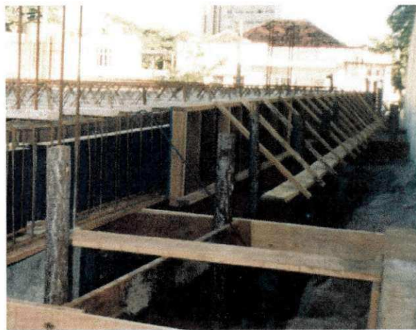
Figura 17 - escora nas formas das vigas
