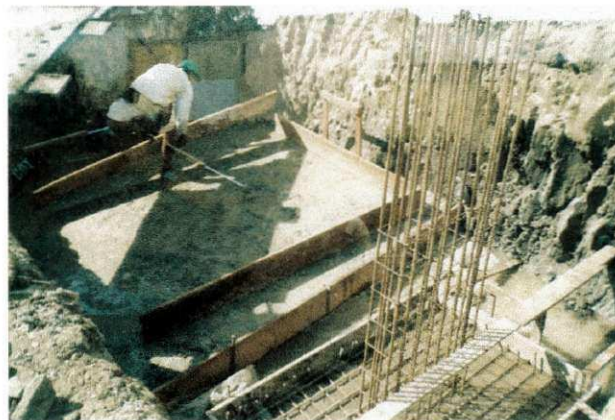
figura 12 – colocação de fôrmas e ferragens.
