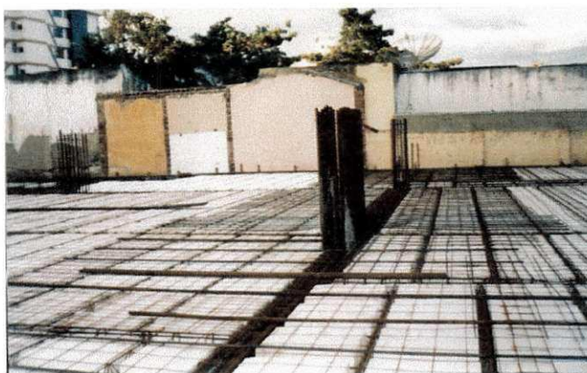
figura 15 c – laje pronta para concretagem.
