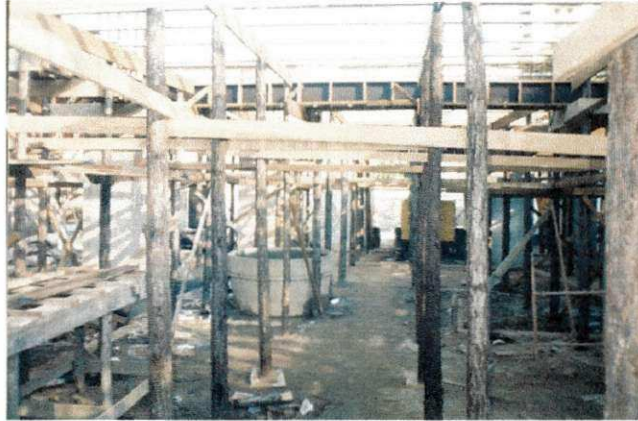
figura 18 – escoramento com pontaletes de pinho
