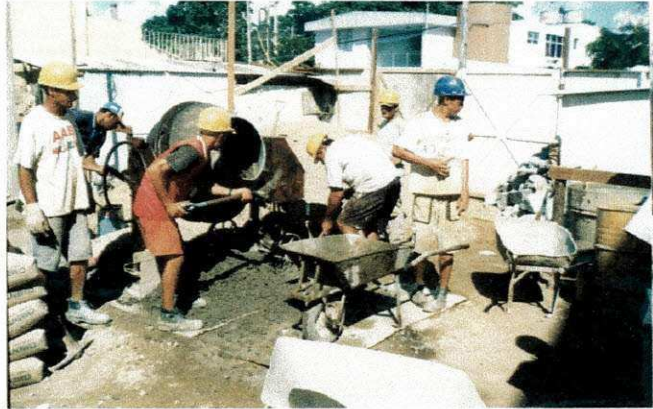
figura 20 – preparo do concreto
