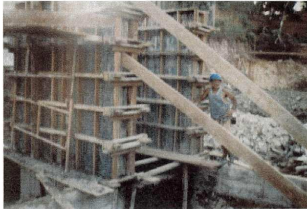
figura 16 – fôrma dos pilares do poço do elevador
