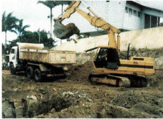
Figura 09 – escavadeira Fonte: pesquisa direta (2003)
