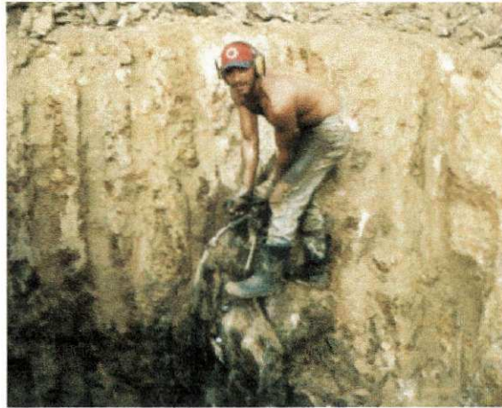
Figura 11 – rompedor pneumático.
