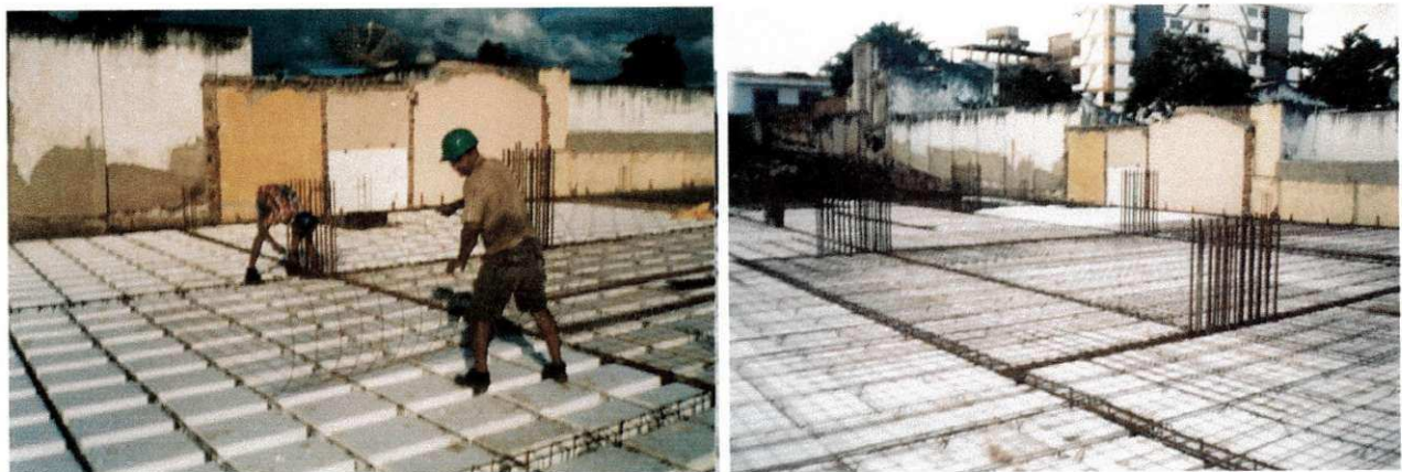
figura 15 b – colocação das armaduras
