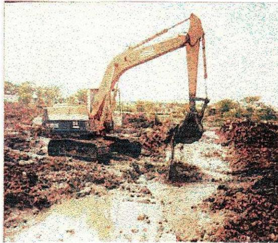
**Foto - 4 e 5 : Limpeza da área com o uso de PC ( retirada de material pantanoso).**
