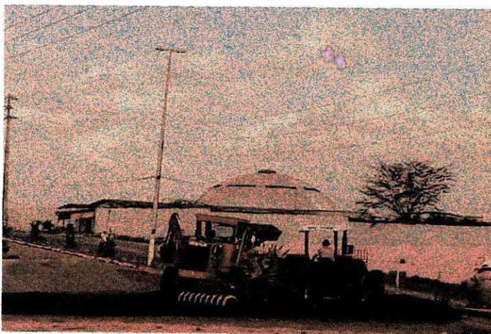
**Foto - 22 :** .... o gradeamento do solo p/ homogeneiza-lo (controle da umidade em todo o trecho)
