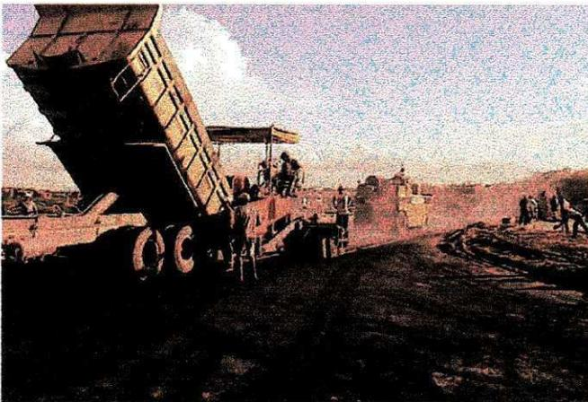
**Foto - 26 : Caminhão caçamba e acabadora em face de execução do revestimento asfáltico (CBUQ), no fundo rolo na compactação da camada.**
