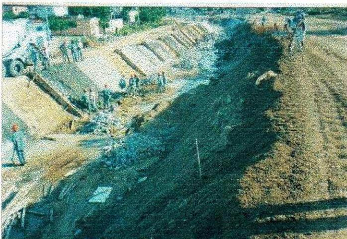
Foto - 9: Lançamento do concreto nas paredes sobre a camada de pedra.
