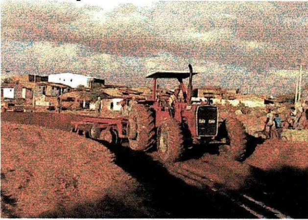
Foto - 18 : Preparação do solo c/ trator de disco (homogeneização do solo)
