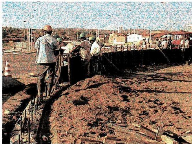
**Foto - 16** : Posicionamento das fôrmas metálicas à espera da concretagem do corpo.
