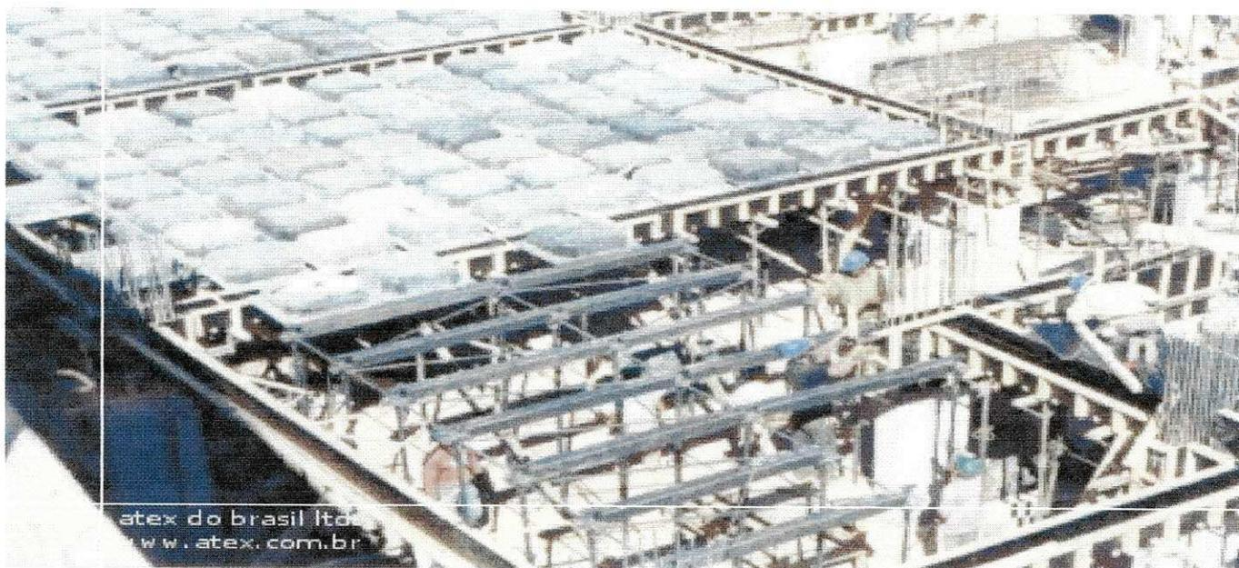
Foto 12 – Nivelamento e Armação da Laje Nervurada.
