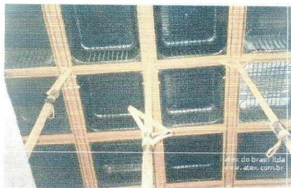
Fotos 10 e 11 - Escoramento Metálico de Lajes Nervuradas.
