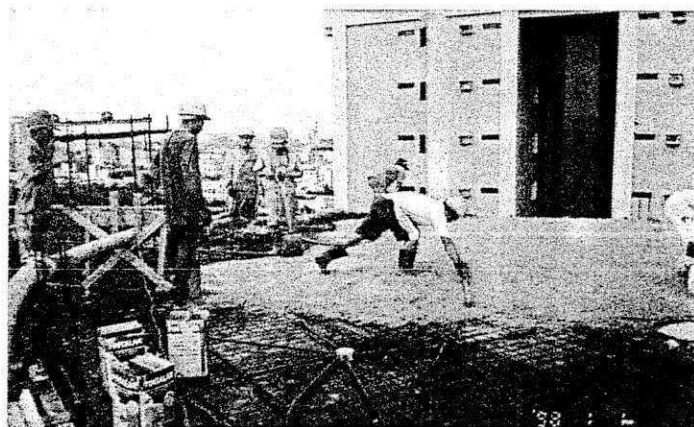
Figura 05 Concretagem da laje da cobertura, Edifício Residencial Abílio Aleixo.
