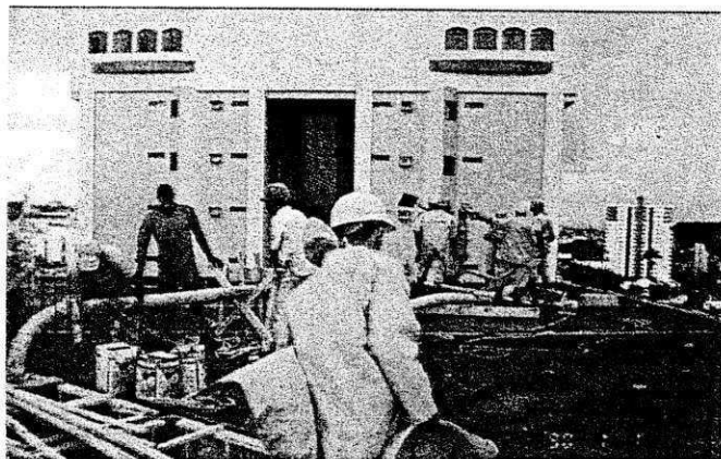
Figura 04 Concretagem da laje da cobertura do Edifício Residencial Abílio Aleixo.
