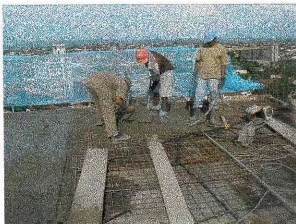
Figura 7 Concretagem da laje
