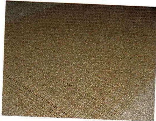
Figura 11 Grelhas para a confecção das lajes
