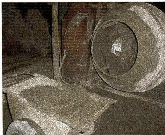
Figura 8 Preparo e transporte do concreto
