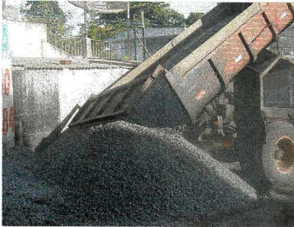
Figura 15 Descarregamento de brita
