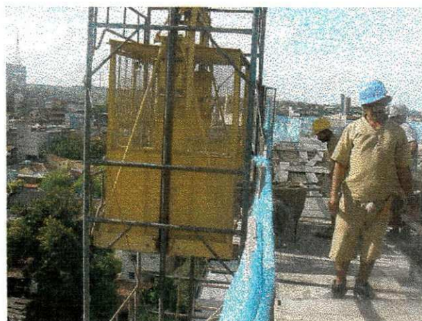
Figura 18 Elevador de carga (gaiola)
