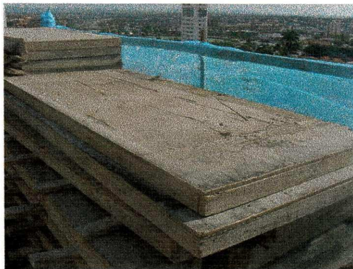
Figura 4 Fôrmas de maderite
