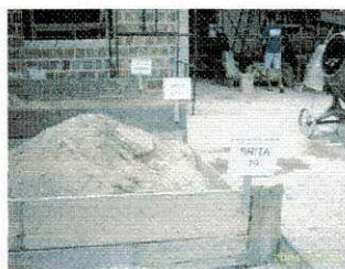
Foto realizada no canteiro de obra durante o processo de qualificação
