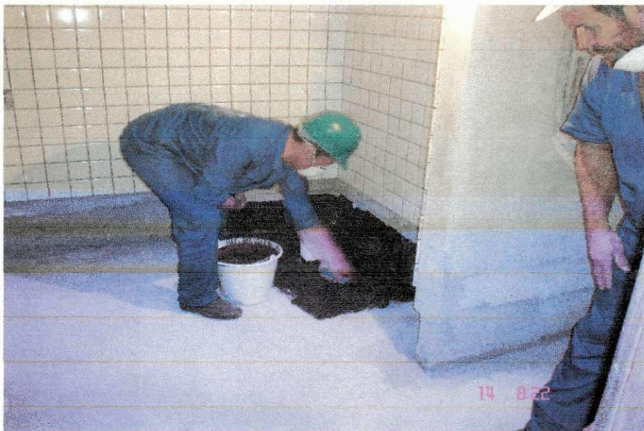
Foto 10 - Impermeabilização dos banheiros com asfalto modificado.
