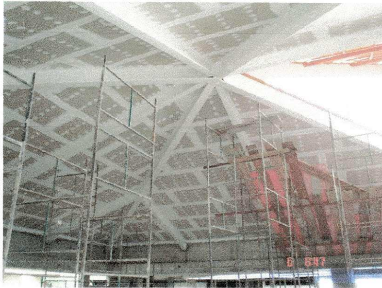
Foto 15 - Gesso acartonado na cobertura do lobby.
