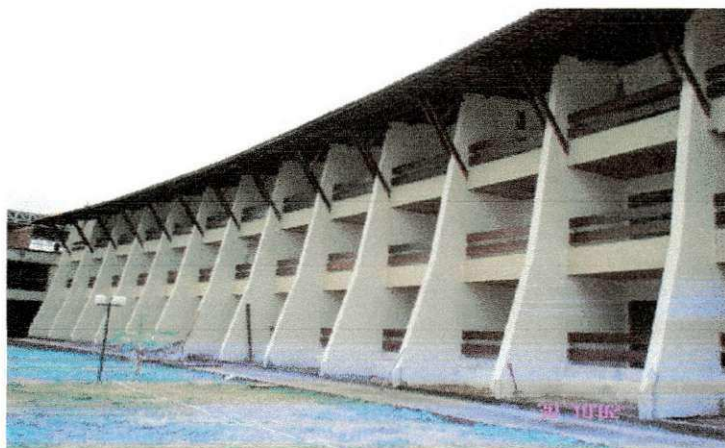
Foto 1 - Ala Sul, vista centro de convenções
