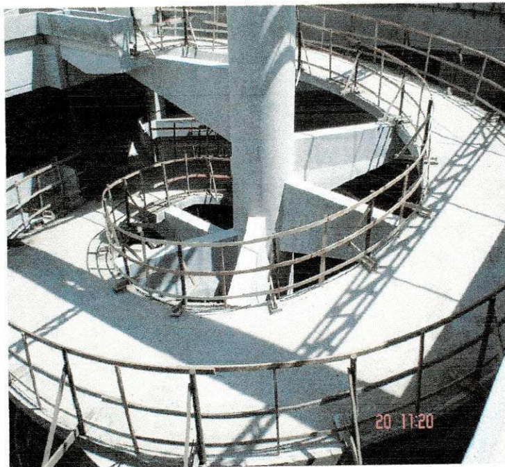
Foto 6 – guarda corpo na rampa helicoidal
