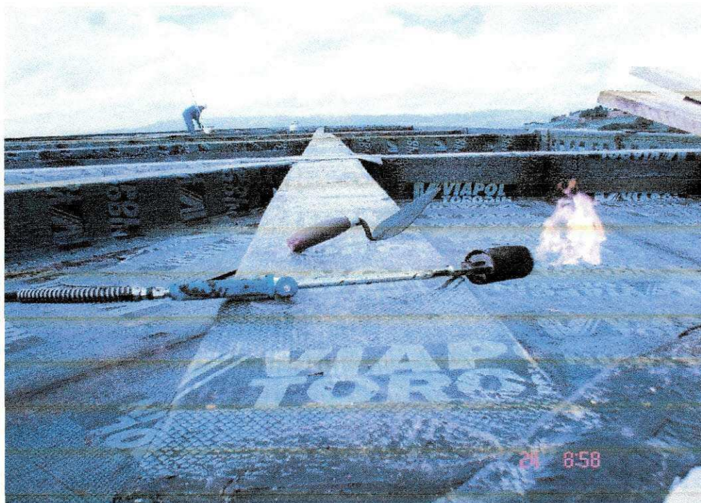
Foto 11 – Impermeabilização de laje com manta asfáltica.
