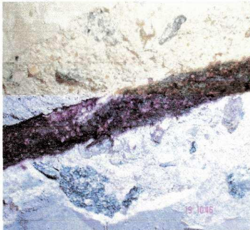
Foto 4 – Corrosão nas armaduras
