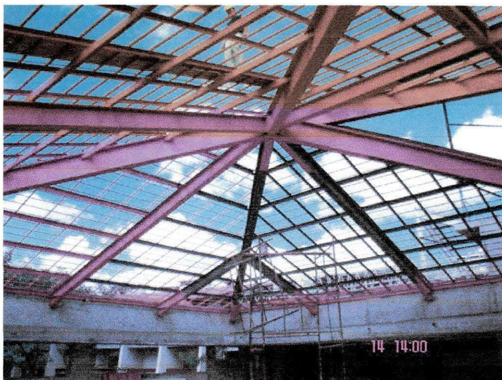
Foto 13 – Aplicação da proteção a base de zinco na estrutura metálica
