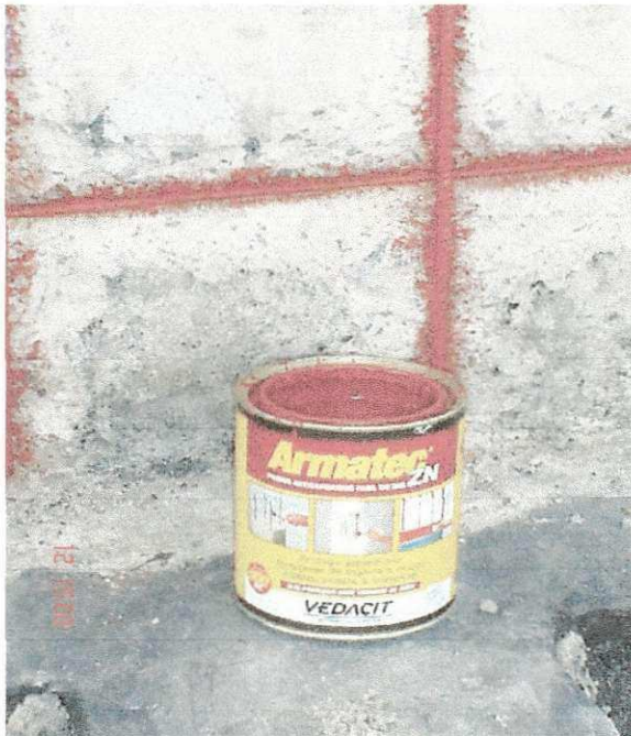
Foto 14 -Produto antioxidante utilizado nas armaduras
