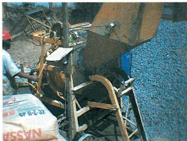
Figura 17: Colocação de materiais na betoneira
