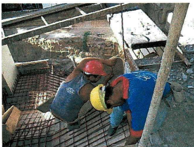
Figura 27: Carpinteiro e ajudante em montagem de escada
