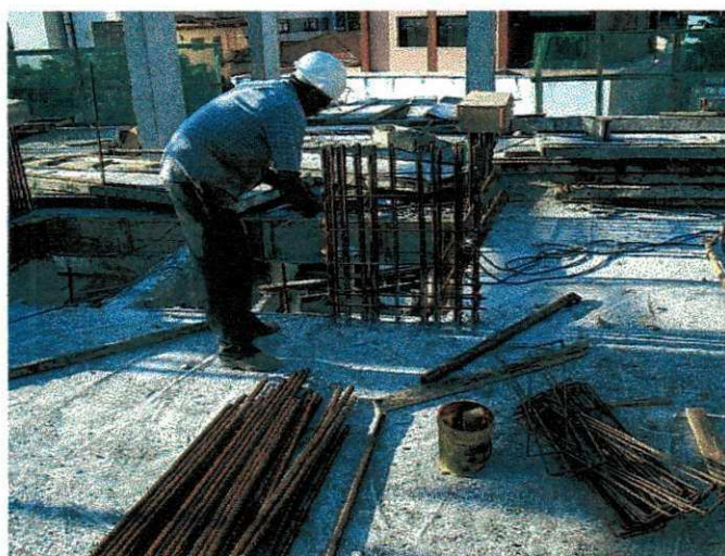
Figura 23: Armação dos pilares
