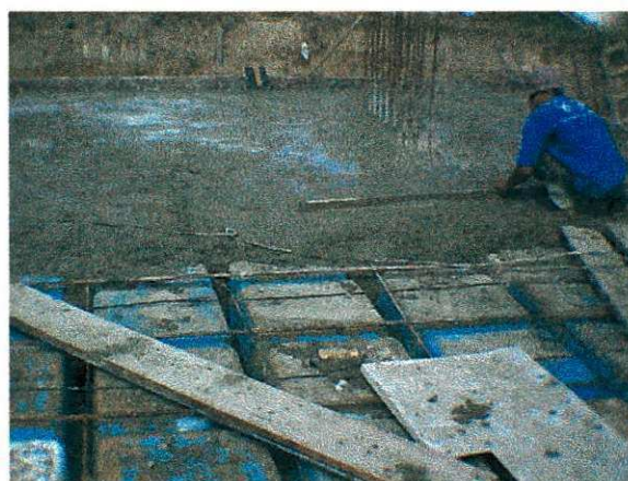
Figura 20: Sarrafeamento do concreto
