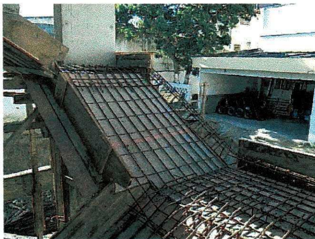
Figura 26: Armação das vigas
