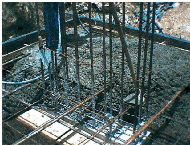
Figura 19: Vibração do concreto
