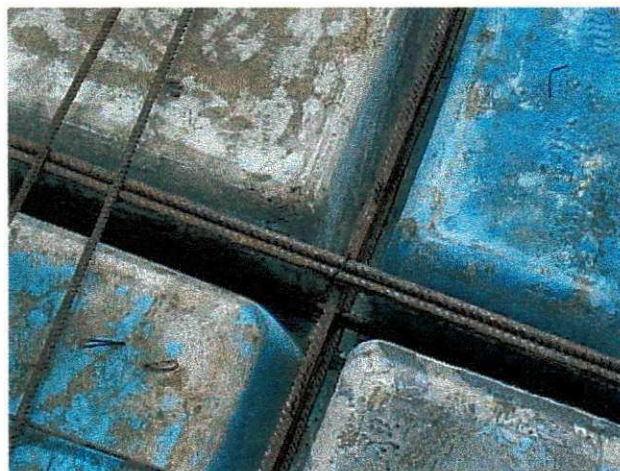
Figura 10: Armadura positiva e negativa
