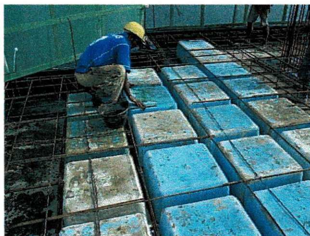
Figura 15: Aplicação de desmoldante
