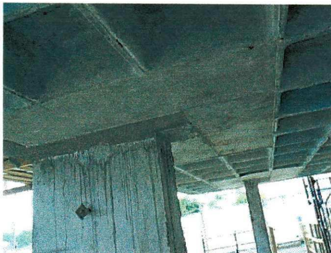
Figura 07: Maciço de pilar
