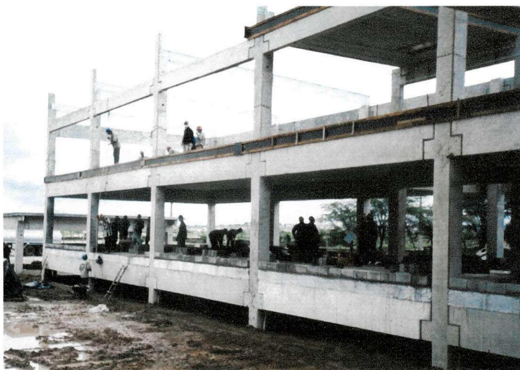
FIGURA 10: Pilares com consolos para recebimento das vigas.
