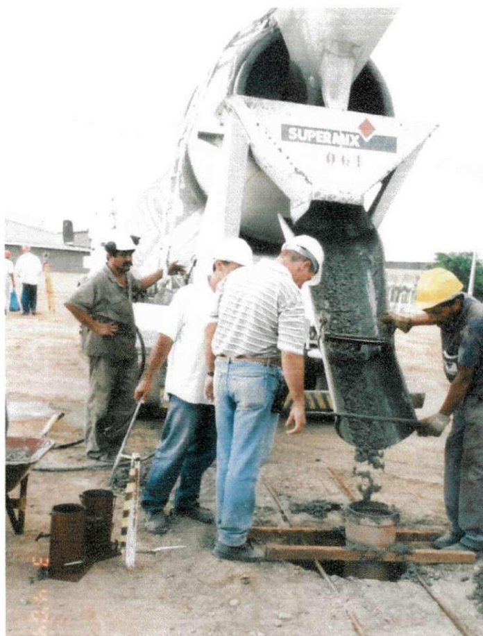
FIGURA 05: Concretagem de um tubulão.
