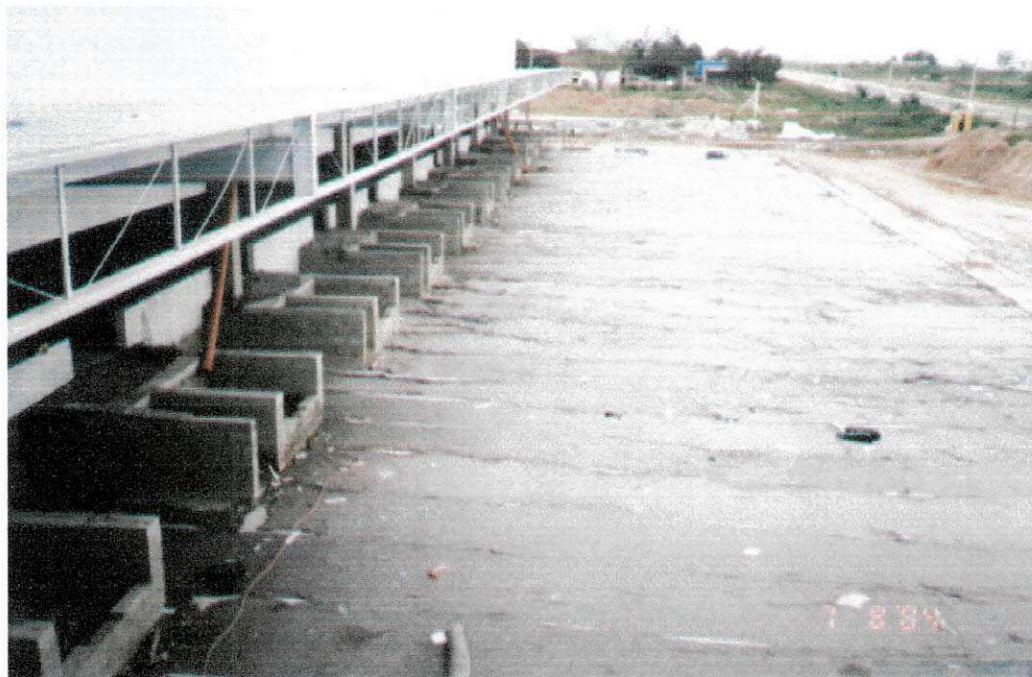
FIGURA 15: Cura úmida com mantas encharcadas.
