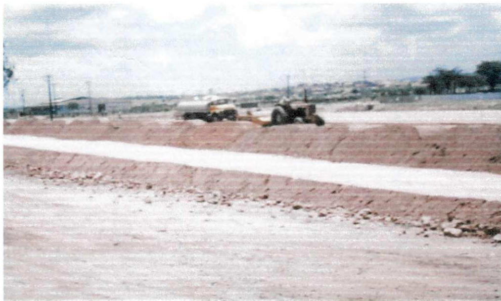
FIGURA 01: Homogeneização de camada por trator de grade de discos e aguação do material por caminhão pipa.
