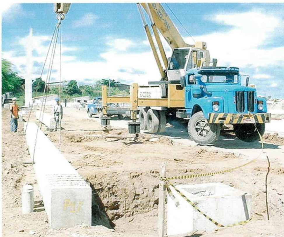
FIGURA 09: Içamento de pilar para montagem. Identificação no fundo do pilar (P17).
