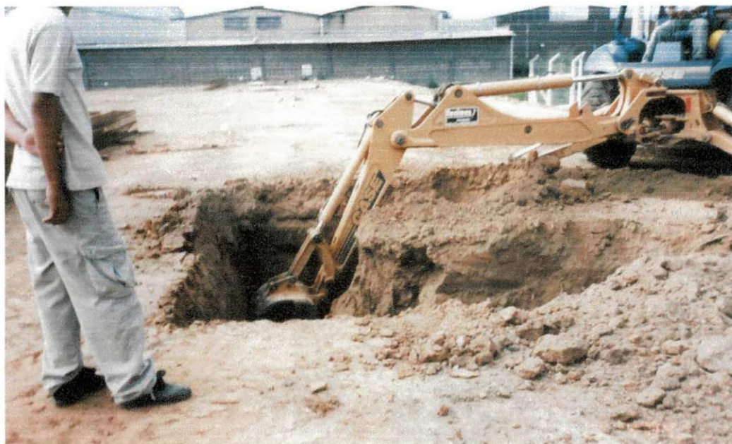
FIGURA 06: Escavação de vala para execução do bloco de coroamento.
