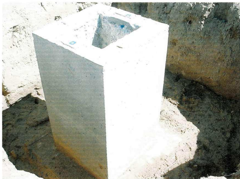
FIGURA 07: Bloco de coroamento com cálice.
