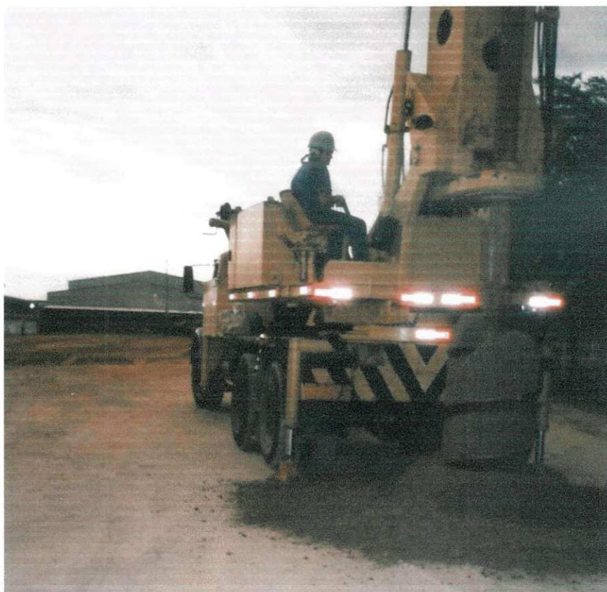
FIGURA 04: Perfuratriz executando poço para tubulão.
