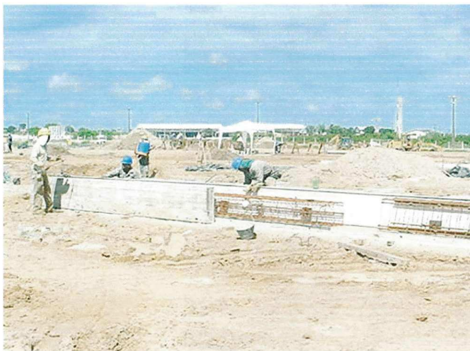
FIGURA 08: Montagem da fôrma para concretagem de pilar sobre base de concreto.
