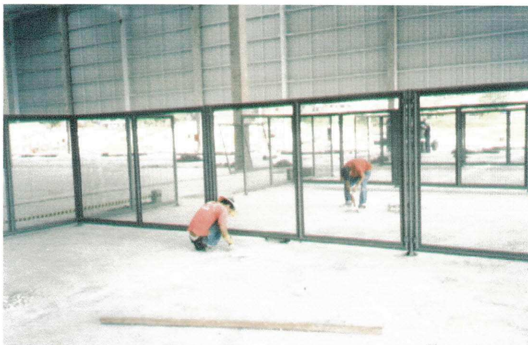
FIGURA 14: Tratamento de junta.
