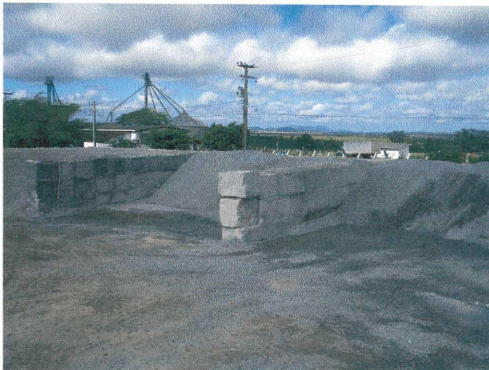
Baias construídas Filial Campina Grande – PB.
