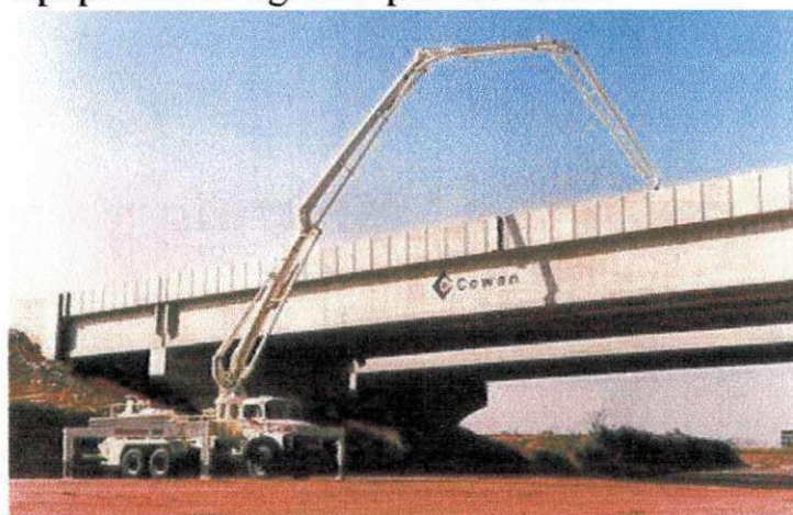
Lancamento Bombeável do Concreto
