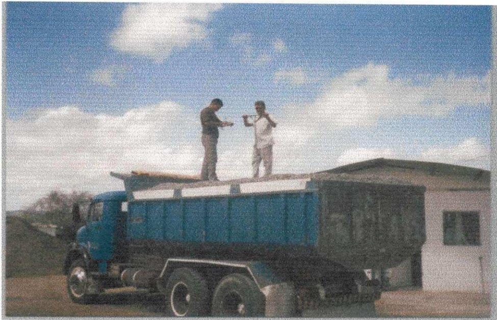
Recebimento do Material (Areia e Brita)
