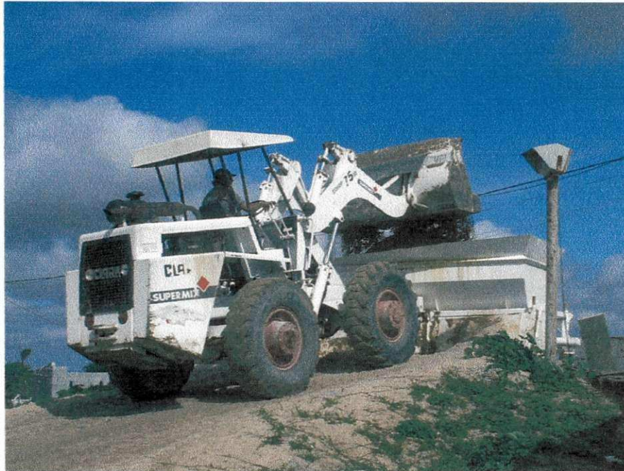
Colocação do Agregado no Silo de Agregado
