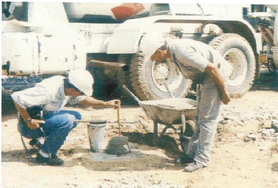
Execução do Slump-Test na Obra
