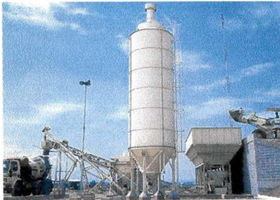
Central de Concreto - Fotusi
