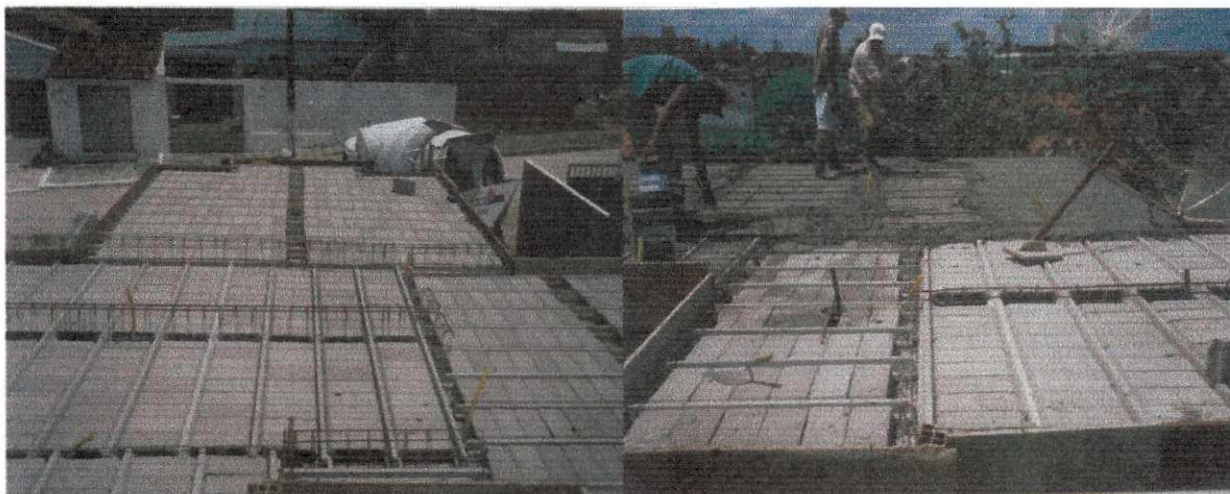
Concretagem de uma obra com laje pré-moldada
