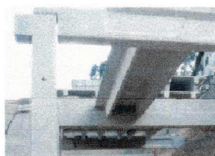
Figura 7.2.2c e 7.2.2.d Operação de montagem de painéis pré-fabricados (cortesia Rodrigues Lima)
