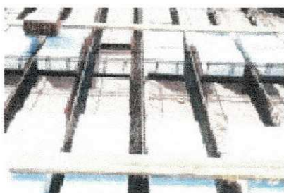
Figura 7.2.3.c e 7.2.3.d Laje nervurada formada por lajes pré-fabricadas com incorporação de blocos de isopor (cortesia lajes Anhangüera) e estrutura de cimbramento de alumínio (cortesia Peri)
