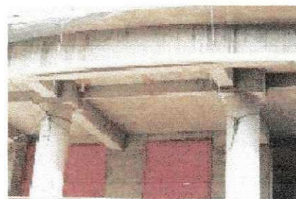
Figura 7.2.1.b Laje maciça e blocos de transição
