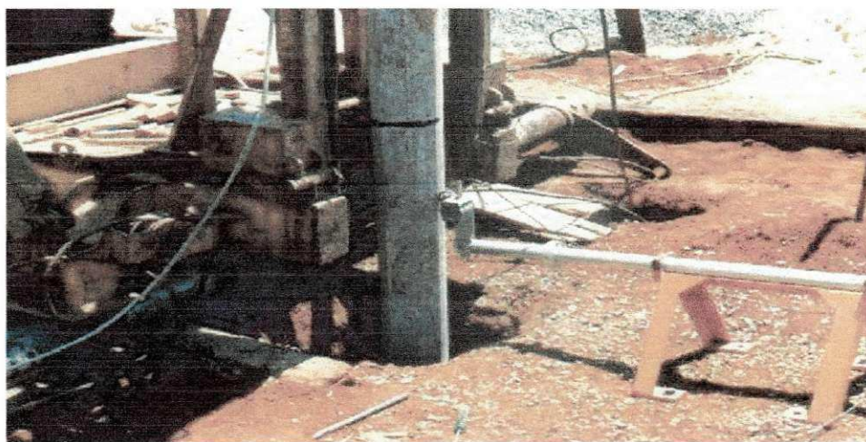
Cravação de estaca pré-moldada.
