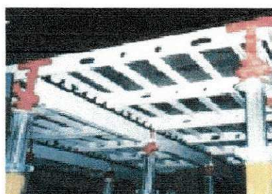
Figura 7.2.3.c e 7.2.3.d Laje nervurada formada por lajes pré-fabricadas com incorporação de blocos de isopor (cortesia lajes Anhangüera) e estrutura de cimbramento de alumínio (cortesia Peri)
