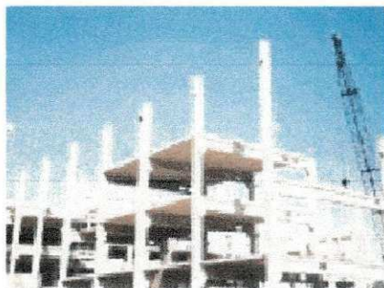
Figura 7.2.2c e 7.2.2.d Operação de montagem de painéis pré-fabricados (cortesia Rodrigues Lima)
