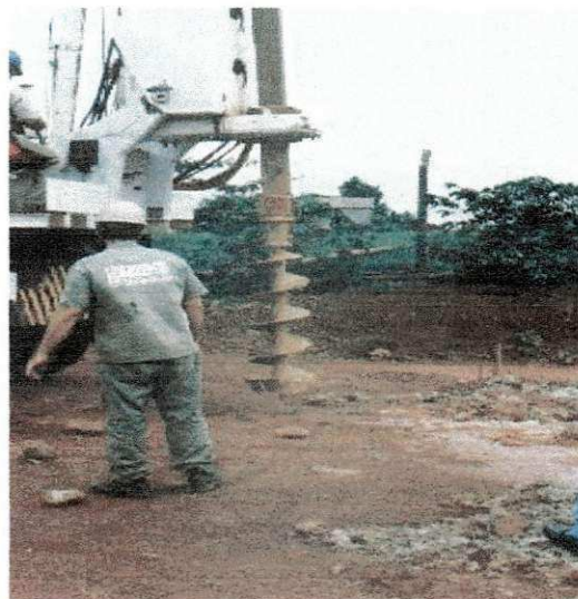
Detalhe do elemento de escavação.
