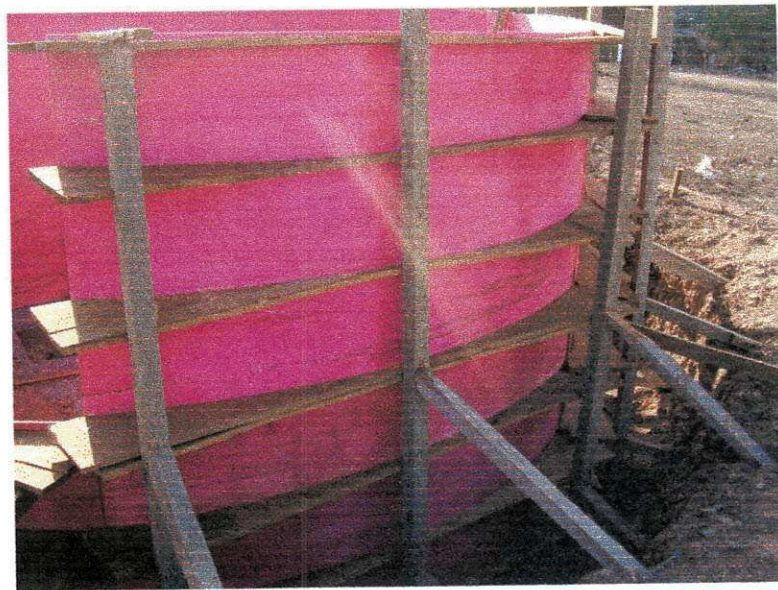
Fig.7 – Fôrmas para o reservatório apoiado.
