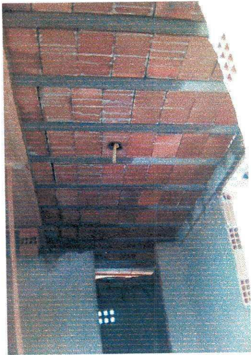
Fig. 1 Laje pré-moldada, reforma na agência de Massaranduba
