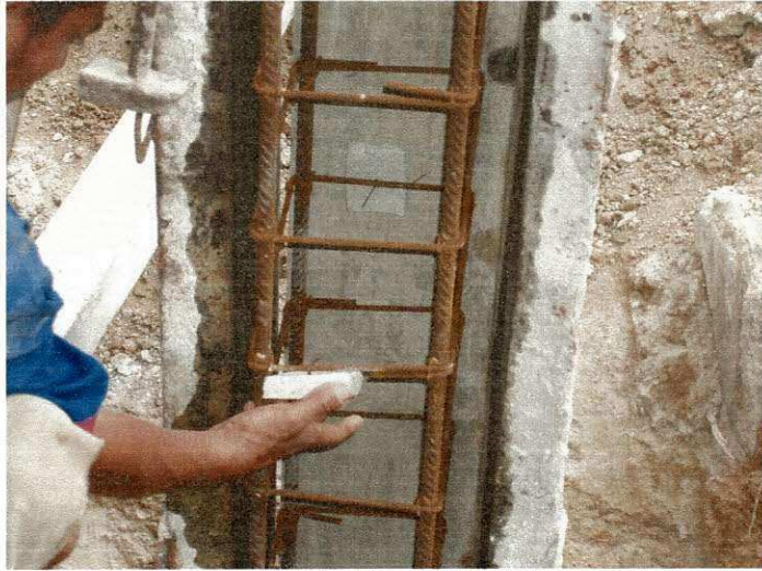
Figura 48 – Colocação das Fôrmas nos Pilares da obra
