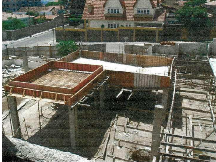
Figura 79 – Estrutura da Piscina
