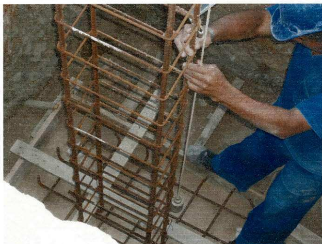
Figura 46 – Esqueleto do pilar e da sapata da obra
