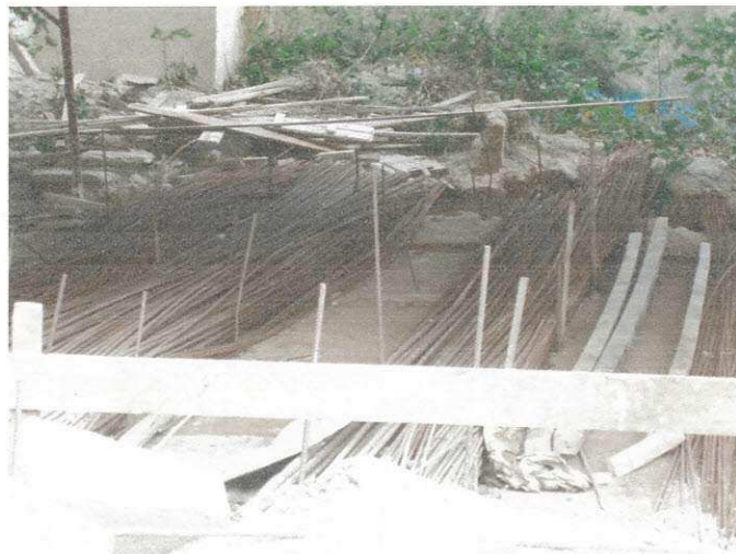
Figura 94 – Ferro usado na obra
