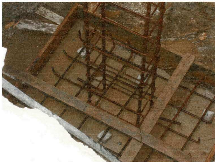
Figura 13 – Ferros do Pilar e da Sapa
