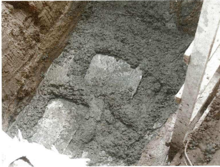
Figura 28 – Nivelamento do buraco de fundação com uso do concreto ciclope
