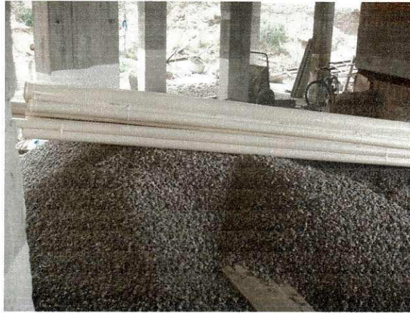
Figura 96 – Agregada graúdo usada na obra
