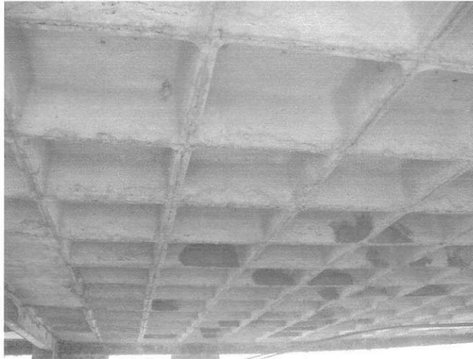
Figura 44 – Laje depois da retirada das Fôrmas
