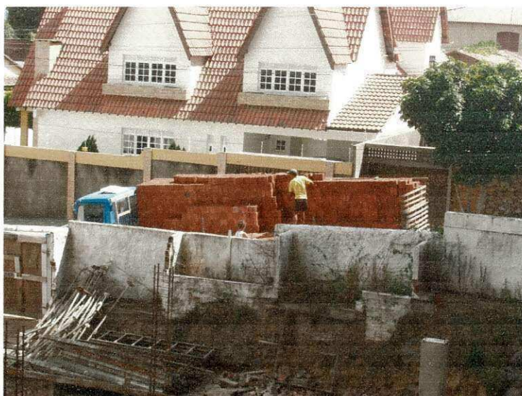
Figura 98 – Tijolos usados na obra
