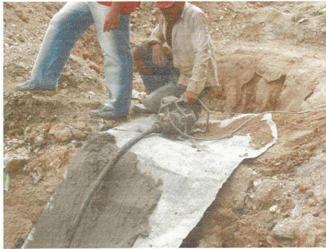
Figura 88 – Vibrador de imersão
