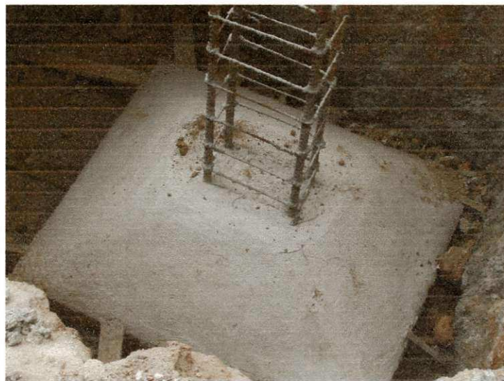
Figura 33 – Sapata pronta
