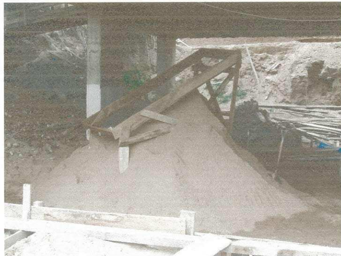
Figura 03 – Depósito de Areia na obra
