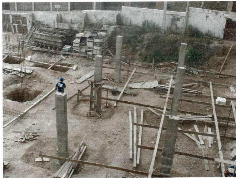
Figura 50 – Pilar após a retirada das Fôrmas
