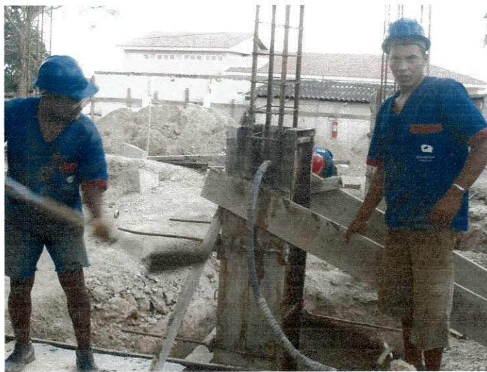
Figura 48 – Colocação das Fôrmas nos Pilares da obra
