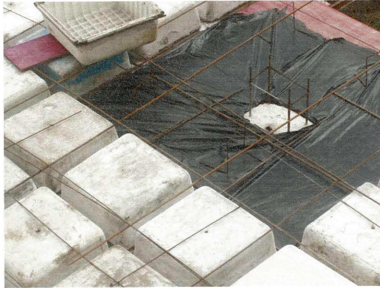
Figura 42 – Colocação das ferragens na laje da obra
