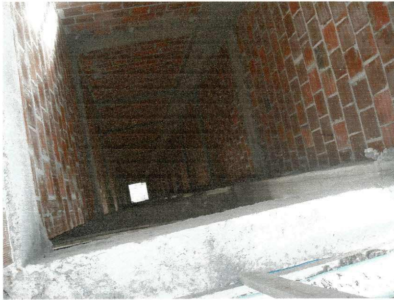
Figura 52 – Fosso do elevador que serve como estrutura de contraventamento
