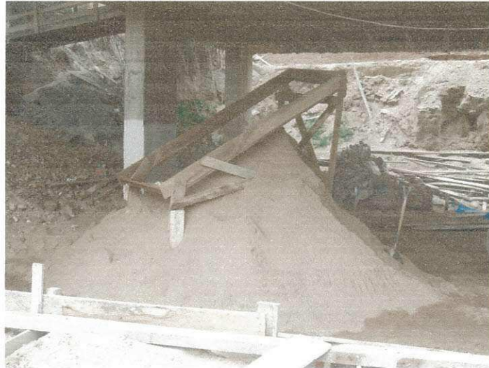
Figura 95 – Areia usada na obra
