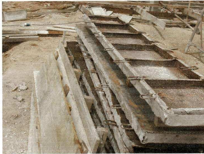
Figura 77 – Fôrmas utilizadas nos pilares
