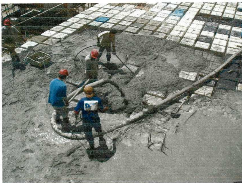
Figura 07 – Fornecimento de Concreto pela concreteira
