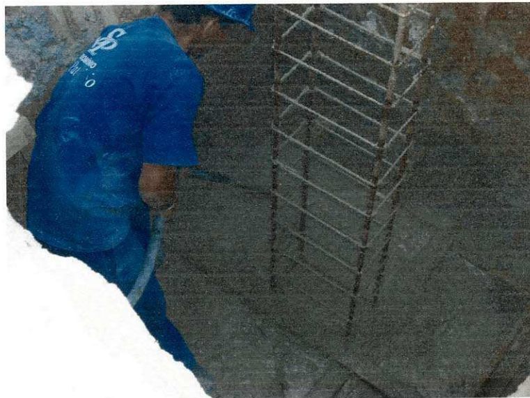
Figura 31 – Concretagem da sapata
