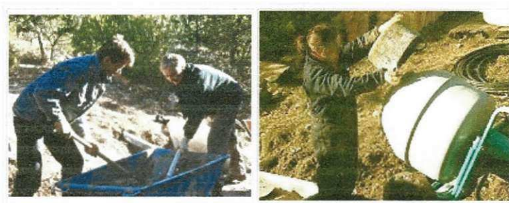
Figura 09 – Concreto virado na obra
