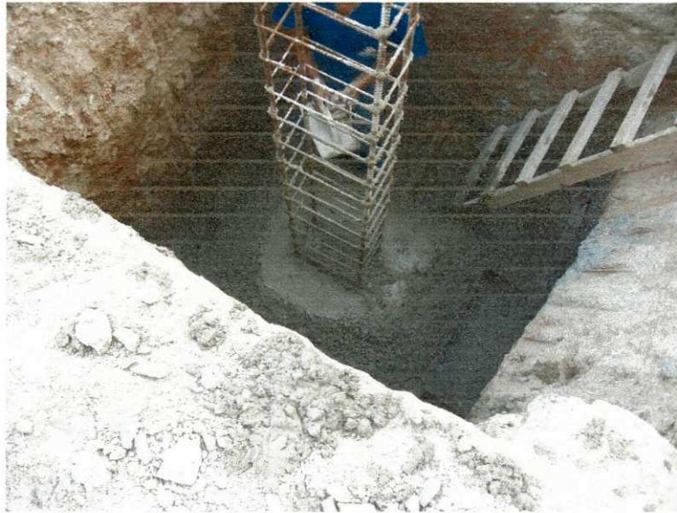
Figura 32 – Acabamento da concretagem da sapata
