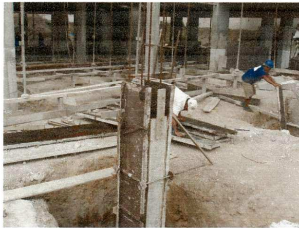
Figura 87 - Fôrmas colocadas nos pilares
