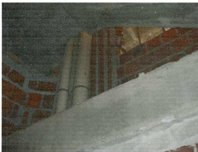
Figura 55 – Instalação hidráulica da obra
