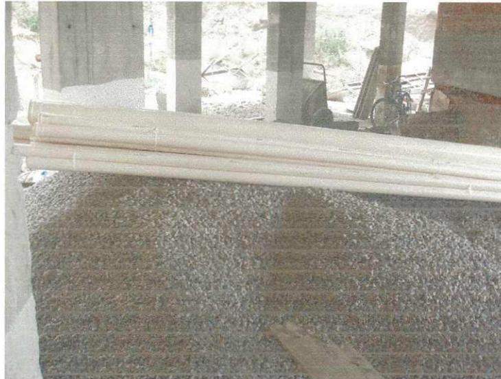
Figura 04 – Depósito de Brita na obra
