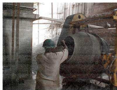
Fotos 70, 71 e 72 - Processo de fabricação do concreto in loco
