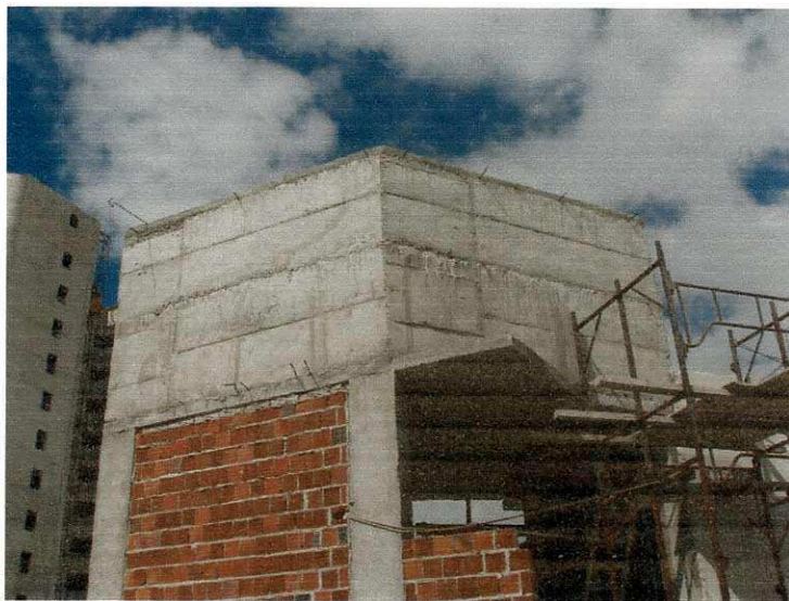
Figura 83 – Reservatório superior
