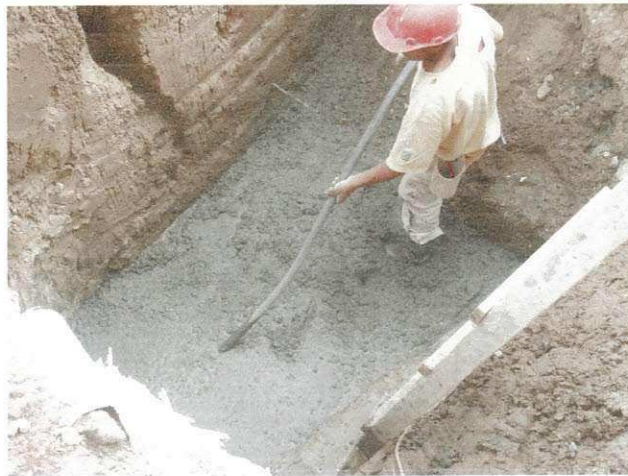
Figura 89 – O vibrador sendo utilizado para vibrar o concreto
