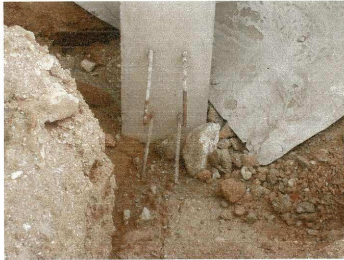
Figura 34 – Ferros de espera que foram colocados para receber as cintas
