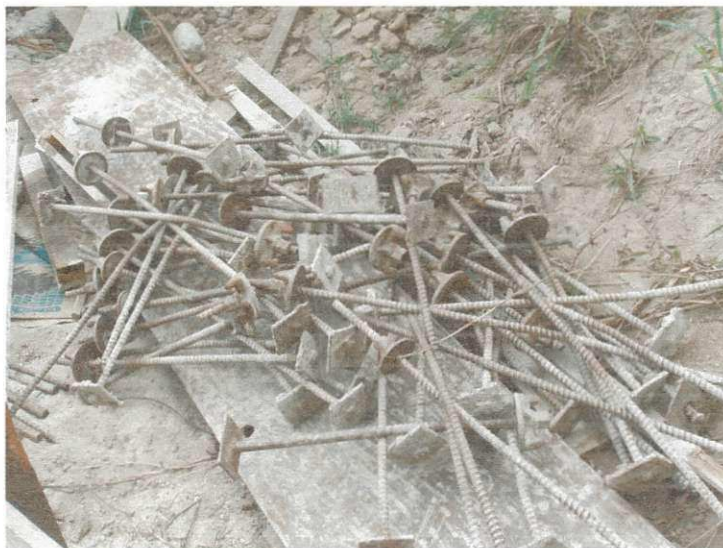
Figura 21 - Dispositiva de encaixe das fôrmas da obra
