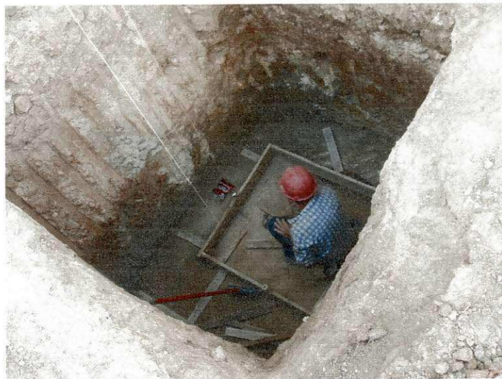
Figura 29 – Alinhamento da sapata no buraco de fundação
