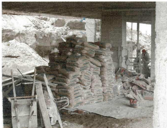
Figura 97 – Cimento usado na obra
