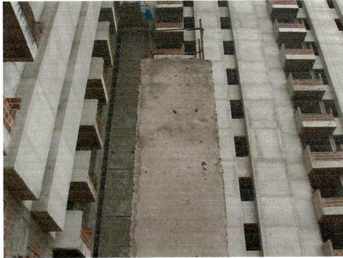
Figura 50 – Pilar após a retirada das Fôrmas
