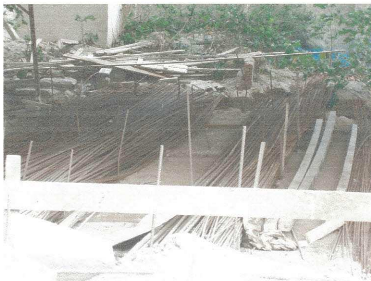
Figura 10 – Armazenamento do Ferro
