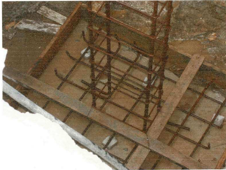
Figura 30 – Grelha da sapata
