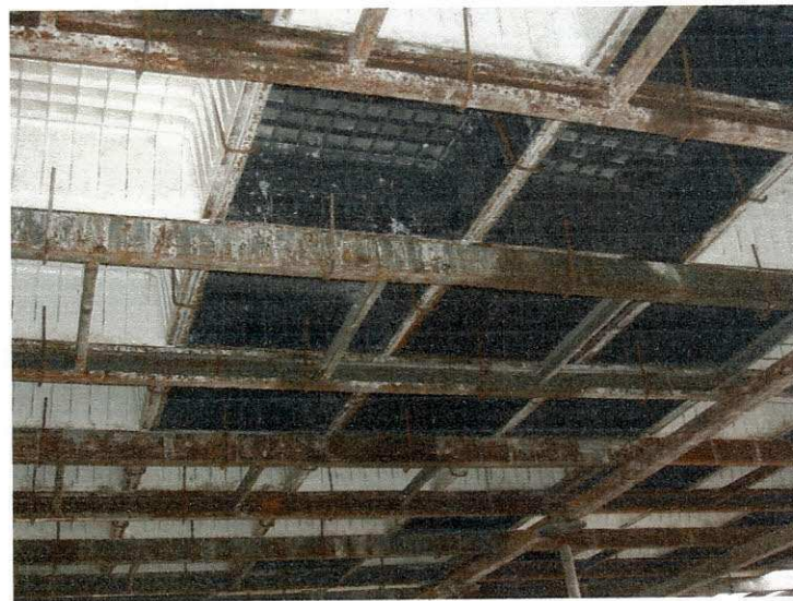
Figura 40 – Estrutura para receber as fôrmas da obra
