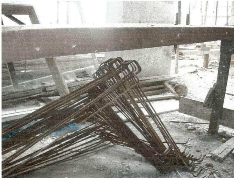
Figura 12 – Ferros da piscina dobrados
