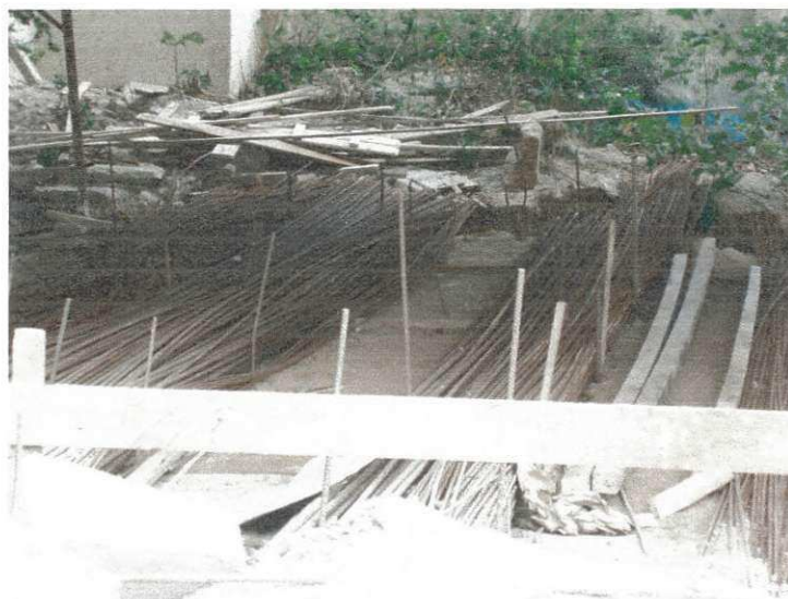
Figura 18 – Ferro da obra
