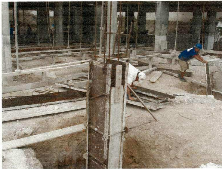
Figura 78 – Pilar ainda com as fôrmas
