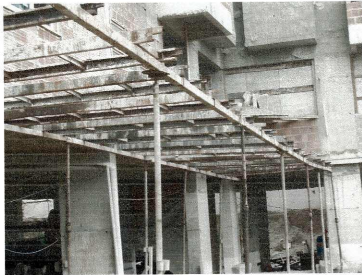
Figura 40 – Estrutura para receber as fôrmas da obra
