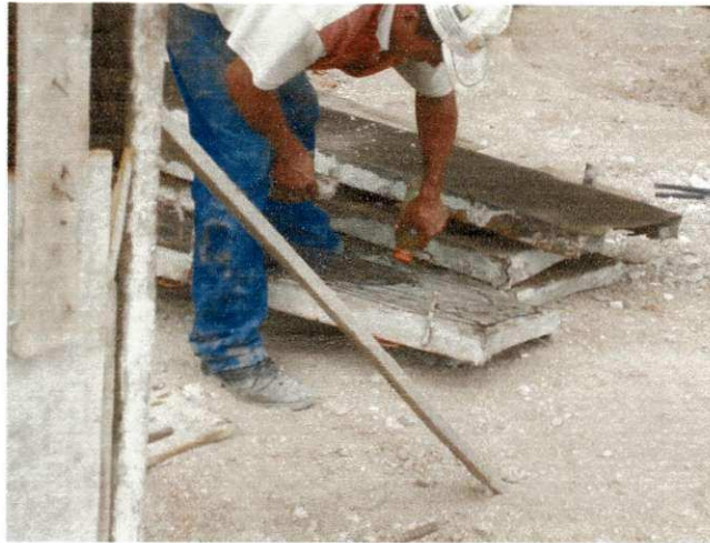
Figura 86 - Fôrmas metálicas dos pilares
