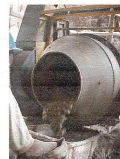
Fotos 70, 71 e 72 - Processo de fabricação do concreto in loco
