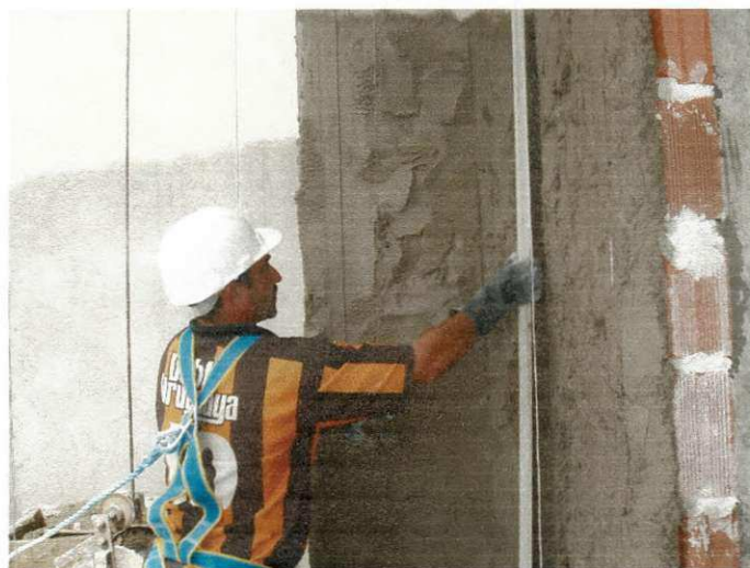
Figura 67 – Reboco na obra
