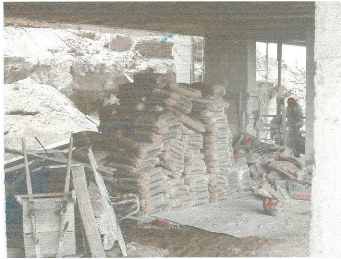
Figura 02 – Depósito de Cimento na obra
