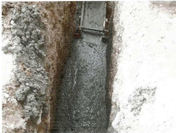
Figura 35 – Concretagem da cinta
