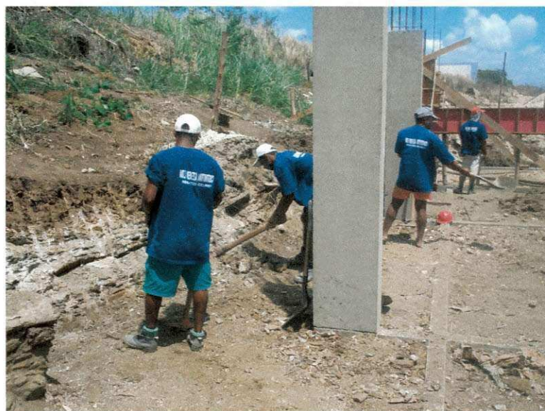
Figura 01: Corte de talude lateral
