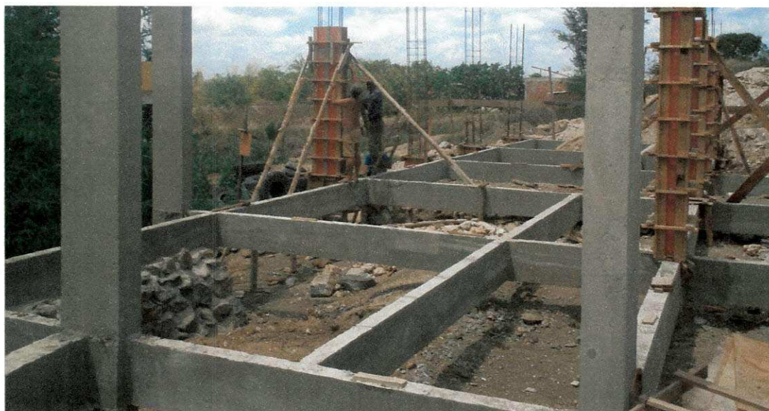
Figura 02: Levantamento em alvenaria de pedra
