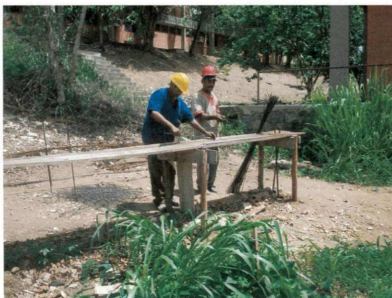
Figura 05: Corte, dobramento e ponteamento da ferragem
