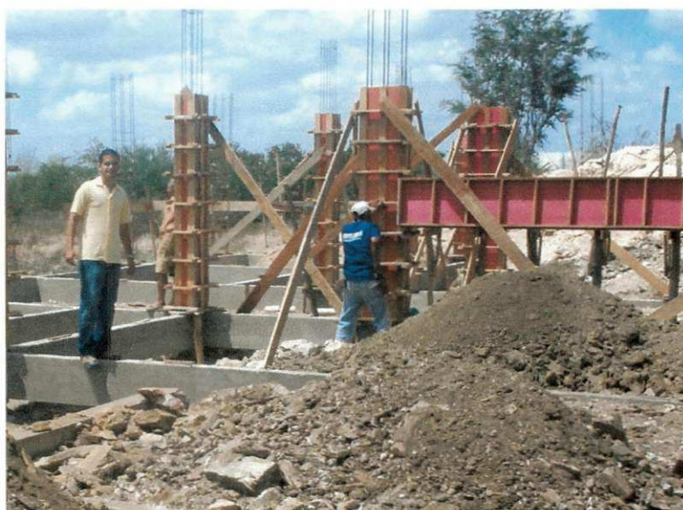
Figura 04: Locação de fôrmas
