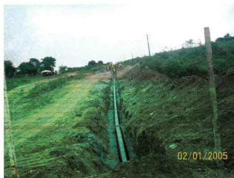
Foto das escavações de valas Autor: Leandro Eudes
