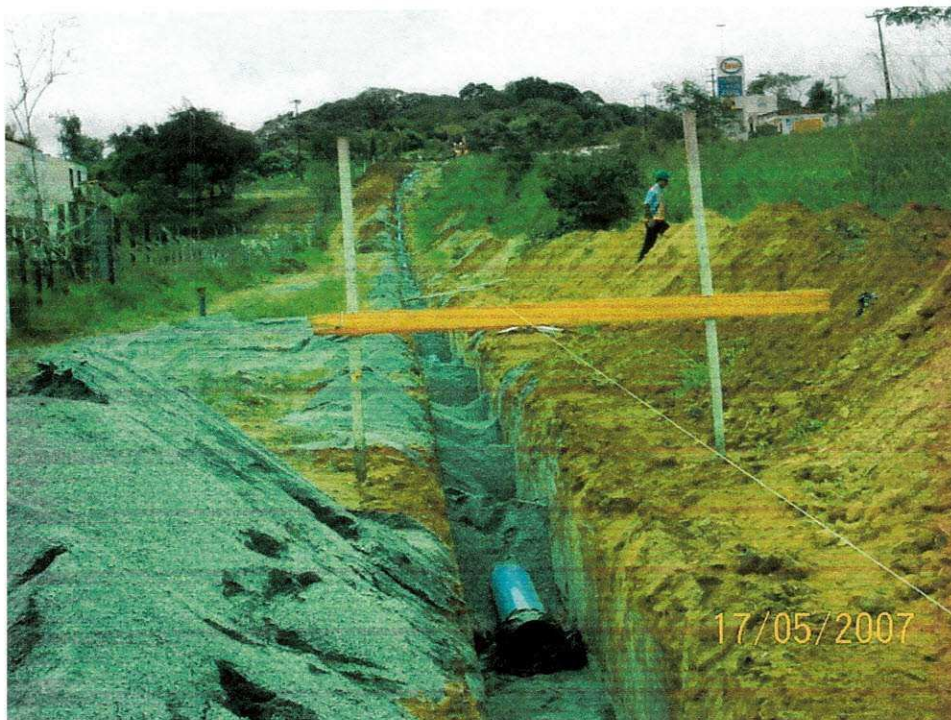
Foto 5: Cobertura da tubulação com pó de pedra Autor da Foto: Leandro Eudes
