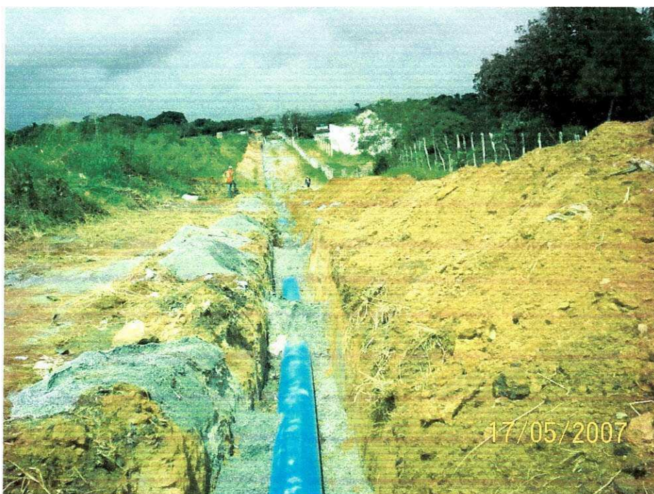
Foto 4: Assentamento da tubulação Autor da Foto: Leandro Eudes
