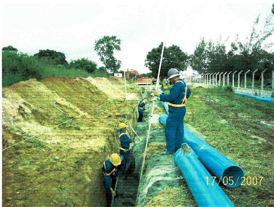
Foto 3: Colocação do pó de pedra Autor da Foto: Leandro Eudes
