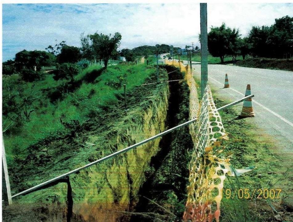
Foto 6: Sinalização com tela e cone para realização da escavação Autor da Foto: Leonardo Eudes
