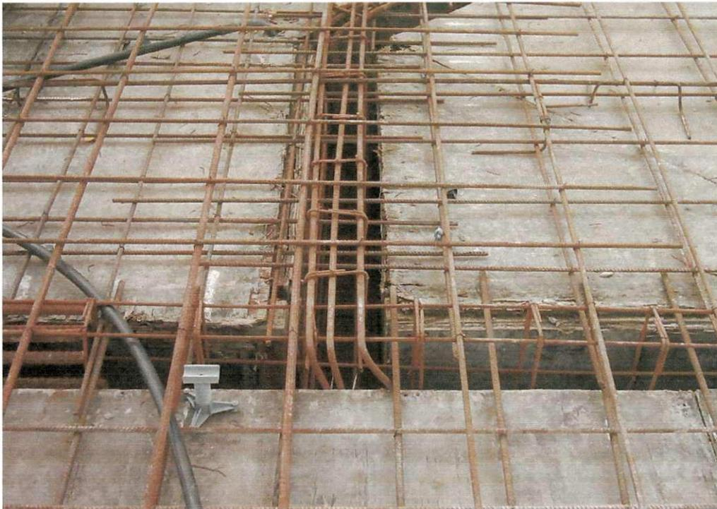
Fig. 5.1 (Mostra a armadura de laje e viga)
