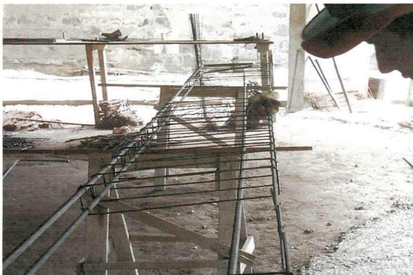
Fig. 7.1 (moldagem das armaduras (vigas) )
