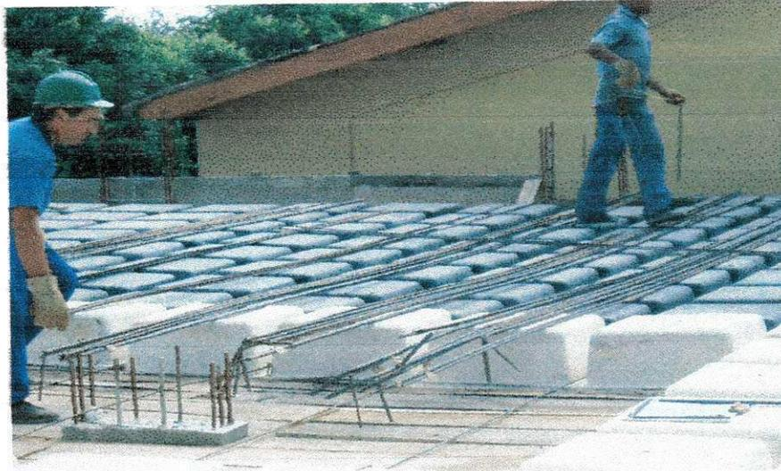
**Figura 23:** Laje do 2º pavimento sendo colocada à ferragem.
