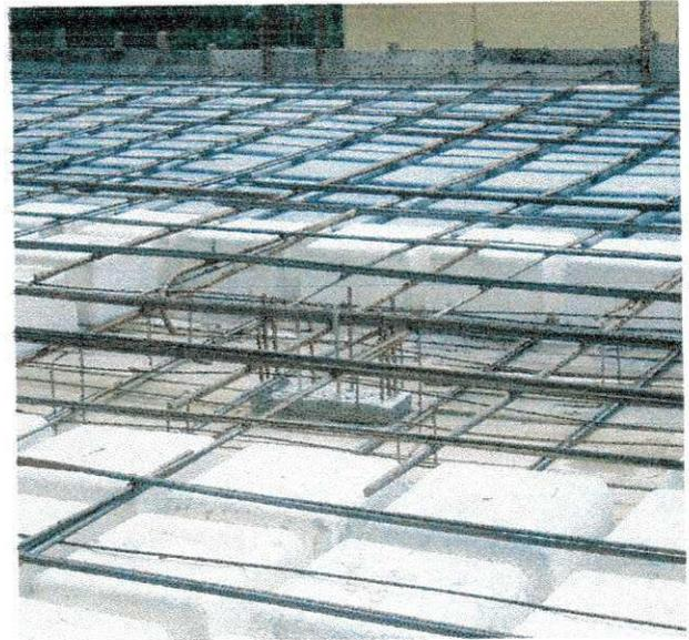
**Figura 24:** Laje do 2º pavimento após da colocação da ferragem
