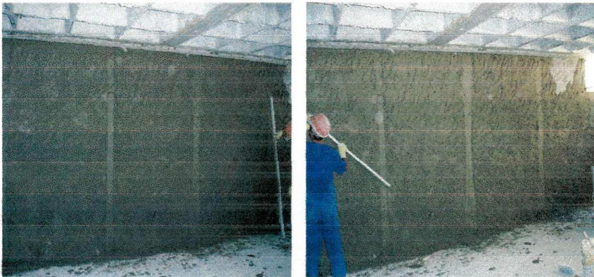
Figura 6: Nivelamento da argamassa com auxílio de régua ( pavimento garagem).
