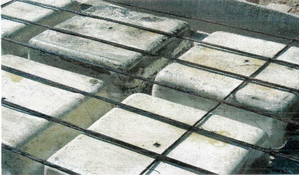
**Figura 25:** Laje do 2º pavimento colocação do desmoldante.
