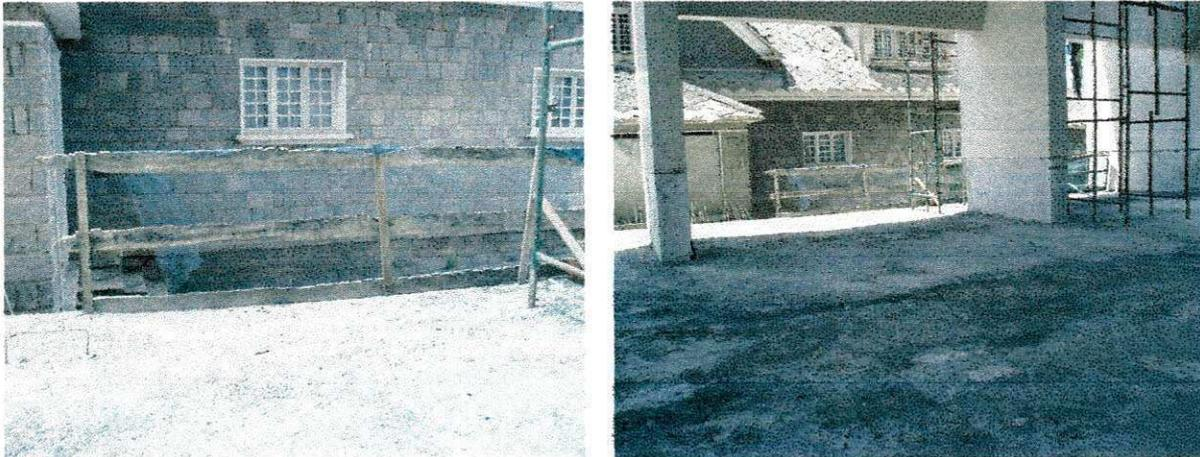
**Figura 29:** Telas de proteção danificadas.
