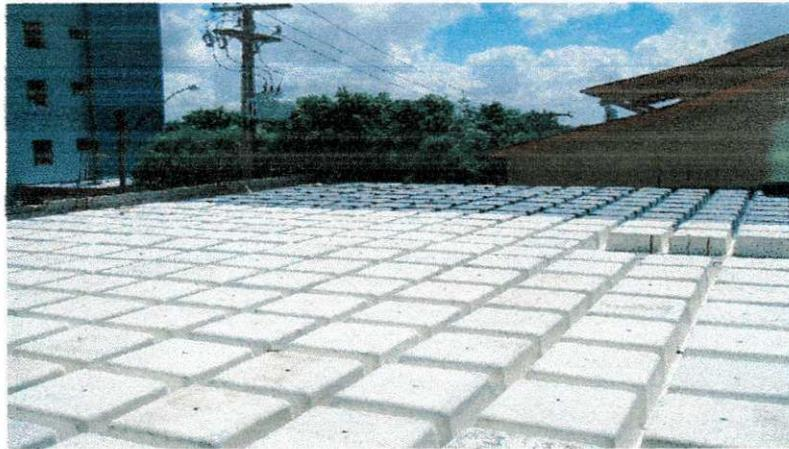
**Figura 22:** Laje do 2º pavimento antes da colocação da ferragem
