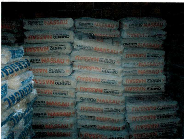
Figura 11- Armazenamento do Cimento na Obra.
