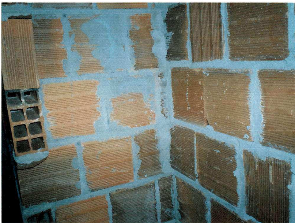
Figura 04- Formação dos cantos da parede na Obra.
