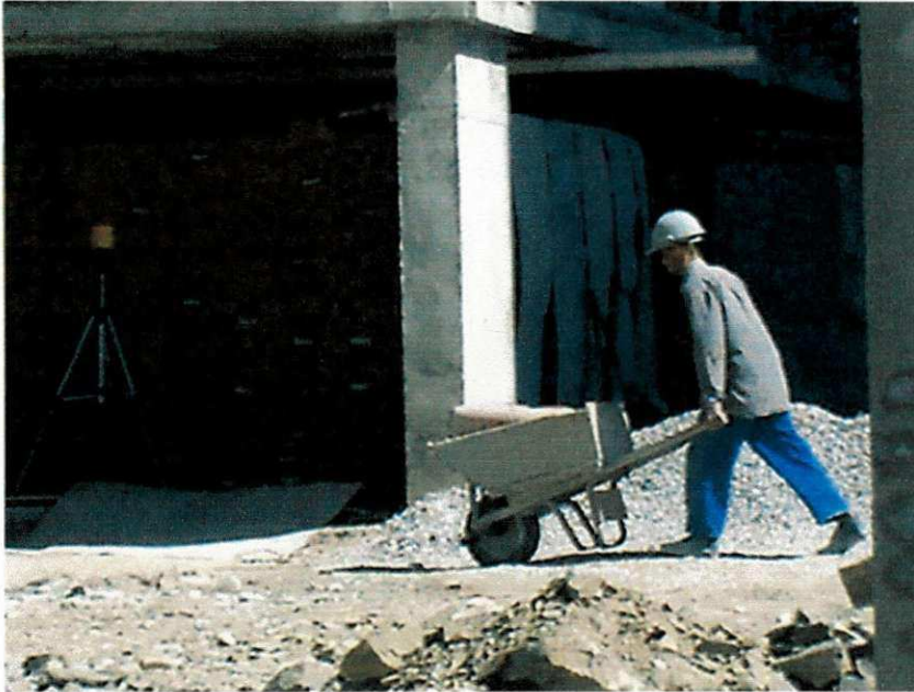
Figura 01- Operário Transportando material (argamassa).
