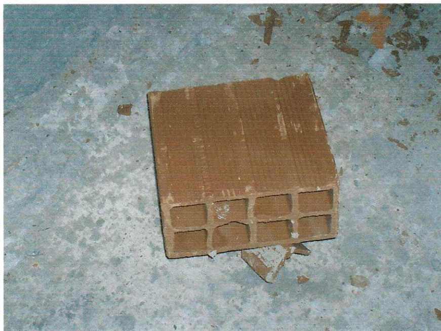
Figura 03- Tijolo com oito furos, utilizados no Edifício Solar da Acácias.
