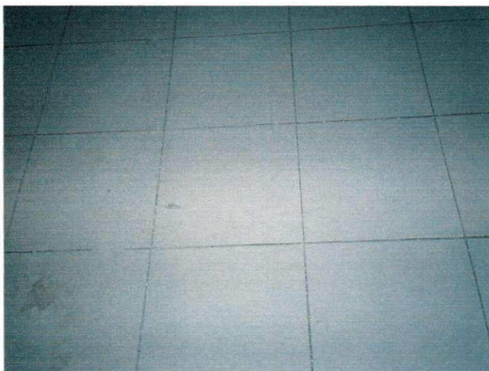
Figura 10- Piso cerâmico executado no Solar das Acácias.
