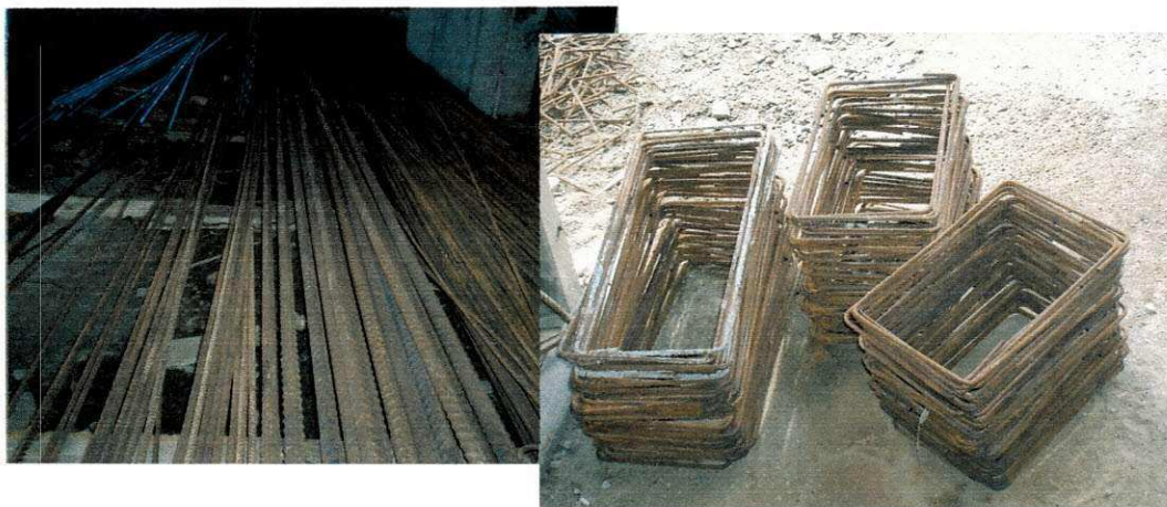
Figura 14- Armaduras e Estribos.
