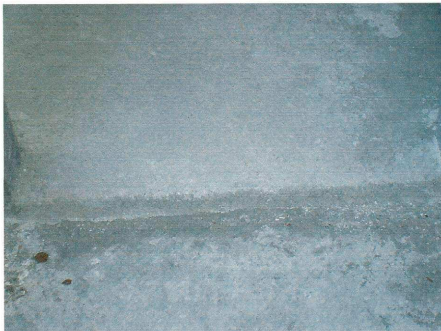
Figura 09- Contrapiso na Obra.
