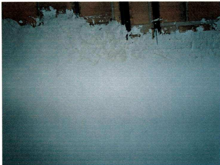
Figura 08- Revestimento Interno dos apartamentos feitos de gesso.
