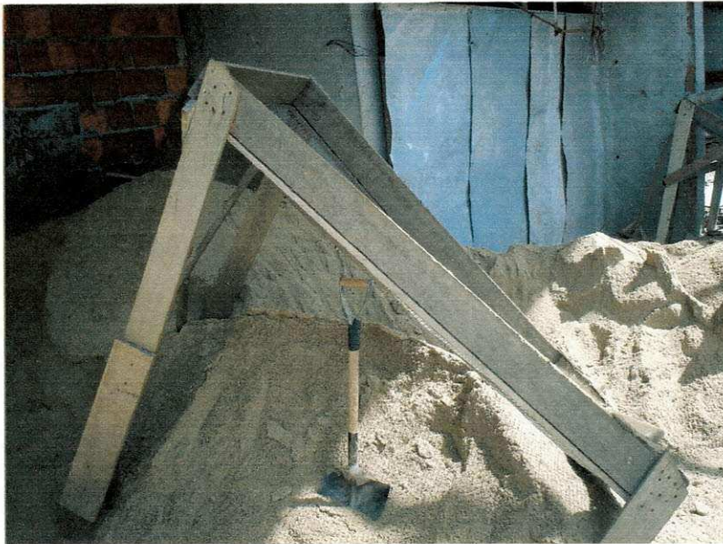
Figura 13- Agregado miúdo usado na Obra.
