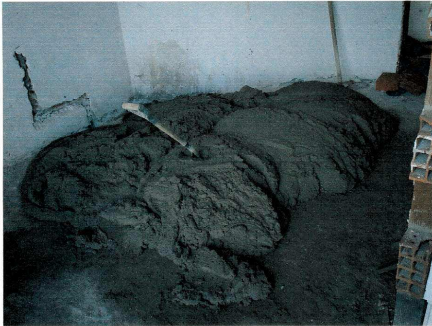
Figura 07- Argamassa para utilização em alvenaria.
