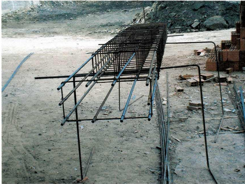
Figura 15- Armadura de Um Pilar na Obra.
