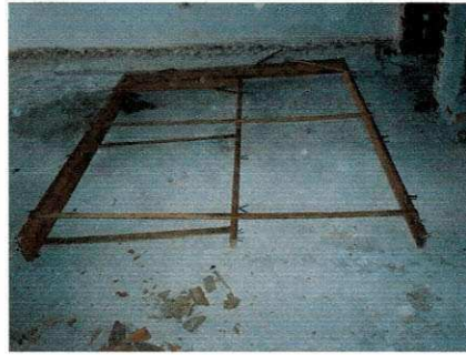
Figura 16- Fôrma para porta.
