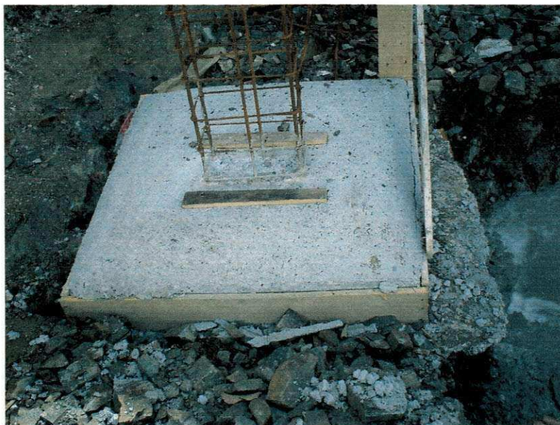
Figura 02- Fundação em sapata, para receber pilar da laje do 1º Pavimento
