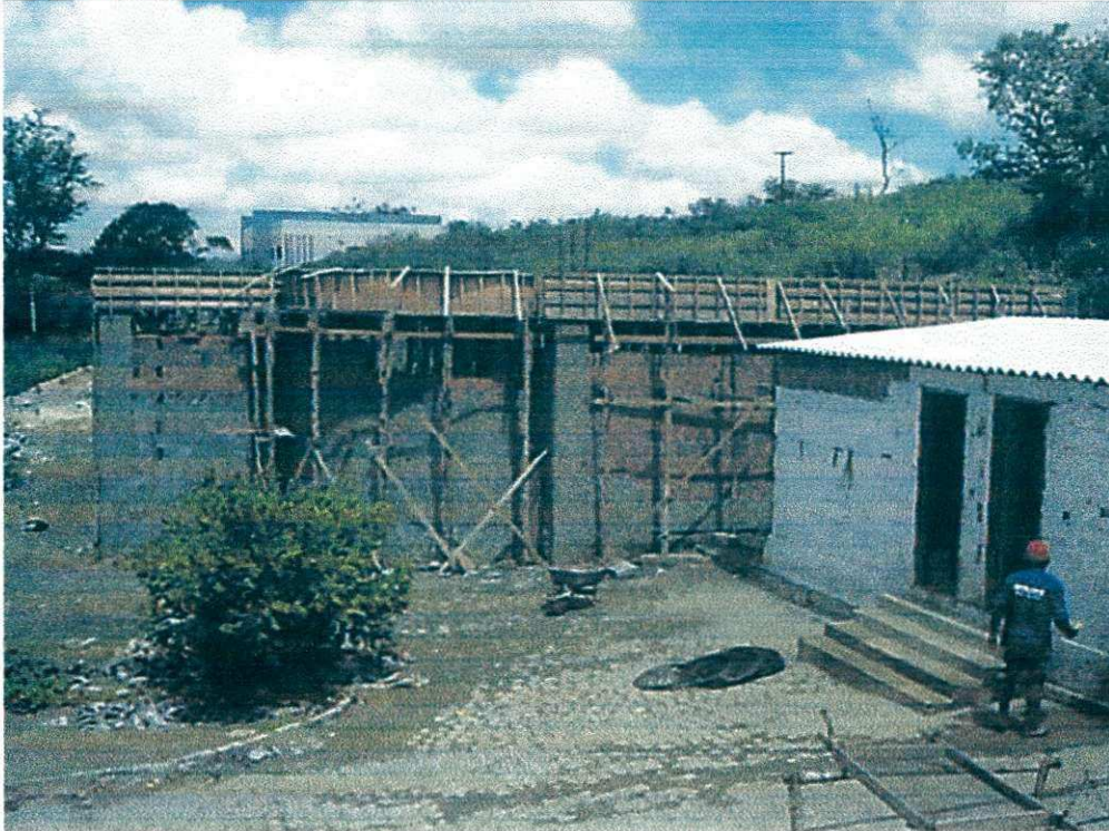
Figura 1.8-Mostra o barracão do canteiro de obras.
