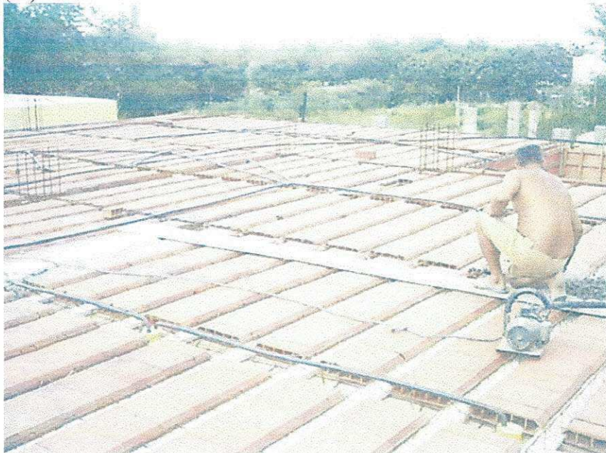
Figura 1.5 (A,B) – Mostra a utilização do vibrador de imersão. (A)
