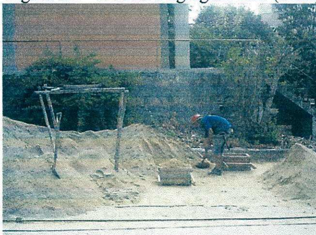
Figura 1.1 – Mostra o agregado fino (areia) sendo peneirado.
