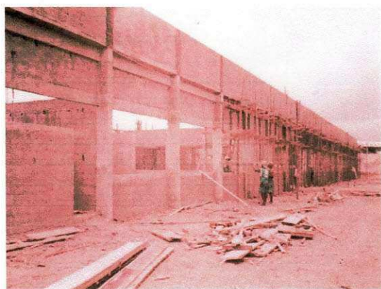
Fig. 5 – vigamentos dos Blocos
