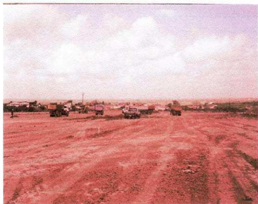
Fig. 1 – Demarcação do terreno
