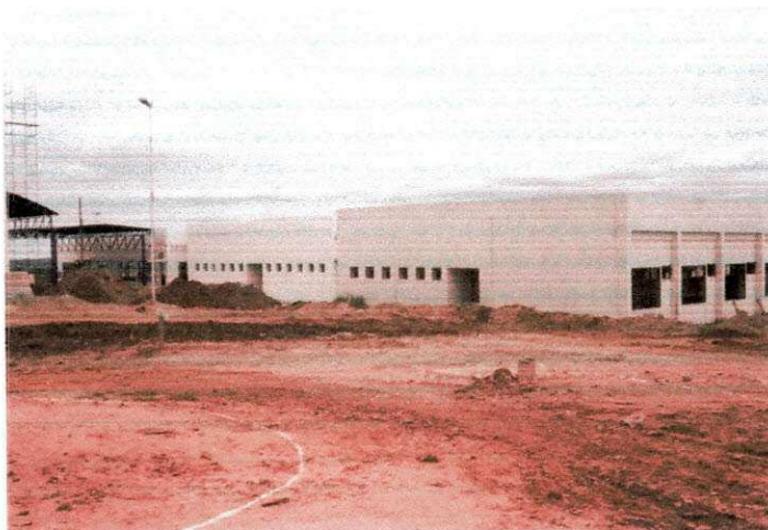
Fig. 7 – Conclusão da alvenaria dos Blocos
