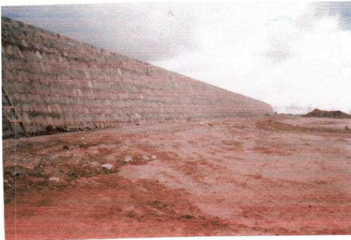
Fig. 7 – Vista da conclusão do muro de arrimo nos Blocos
