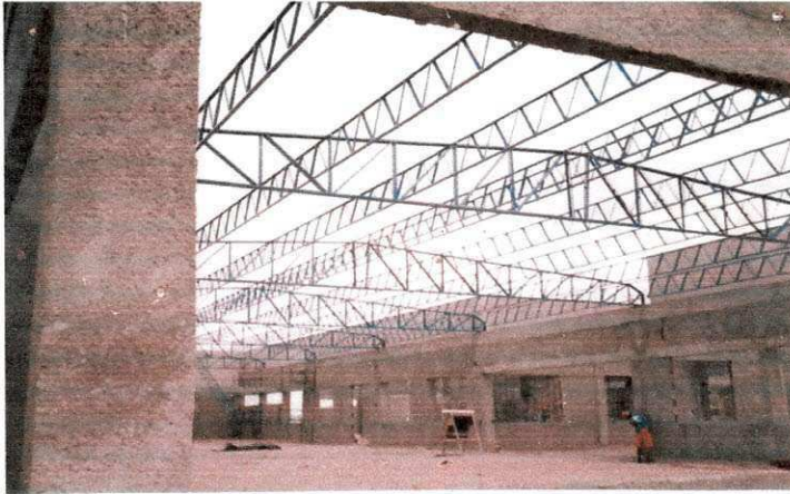
Fig. 6 – Montagem das estruturas metálicas
