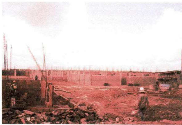
Fig. 2 – Levante das alvenarias;
