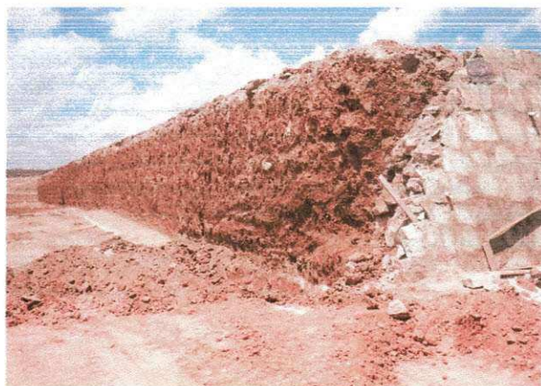
Fig. 4 – Construção do muro de arrimo
