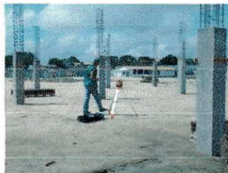
Foto 14: Equipamento para medir o nível do terreno
