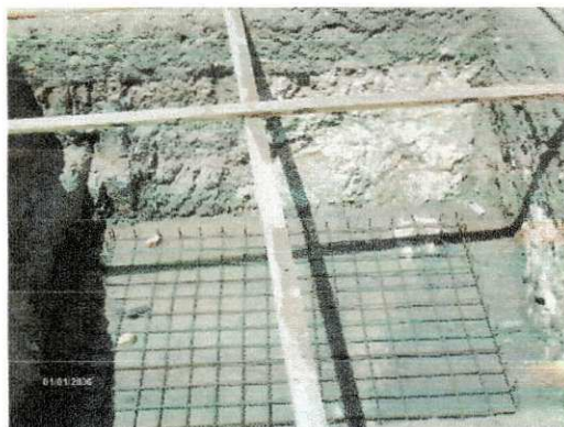
Foto 05: Armação das sapatas
