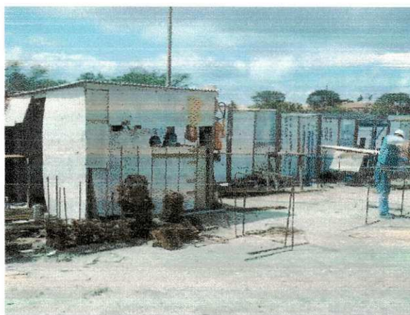
Foto 02: Canteiro de Obras
