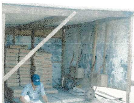
Foto 19: Abrigo para armazenamento do cimento
