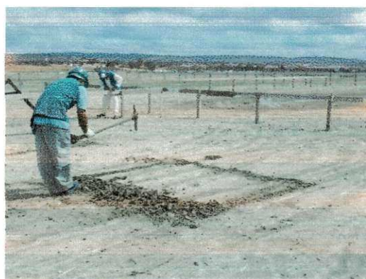
Foto 01 (Locação da Obra)
