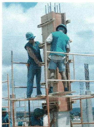
Foto 10: Montagem das formas
