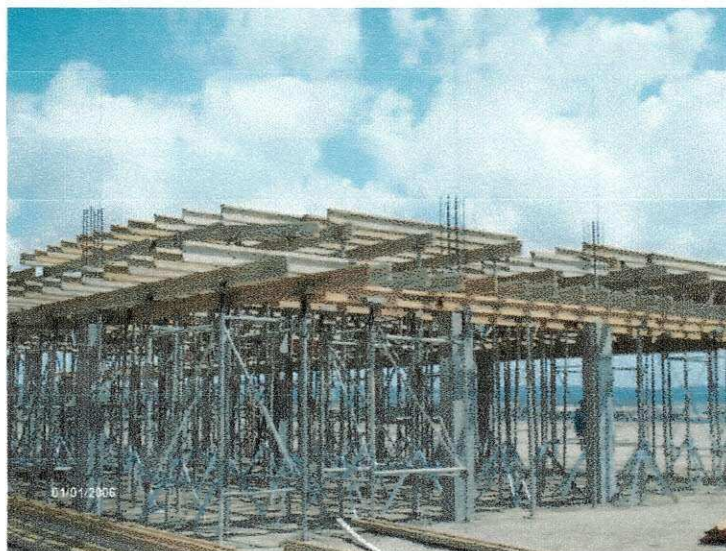
Foto 08: Formas para lajes e vigas.
