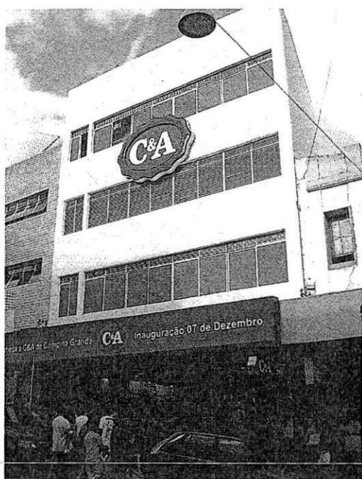
Foto 3 – Fachada Secundária – Rua Maciel Pinheiro.
