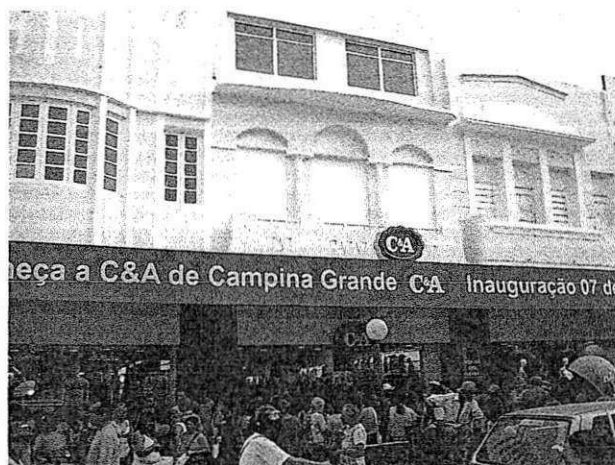
Foto 4 – Fachada Principal – Rua Venâncio Neiva.
