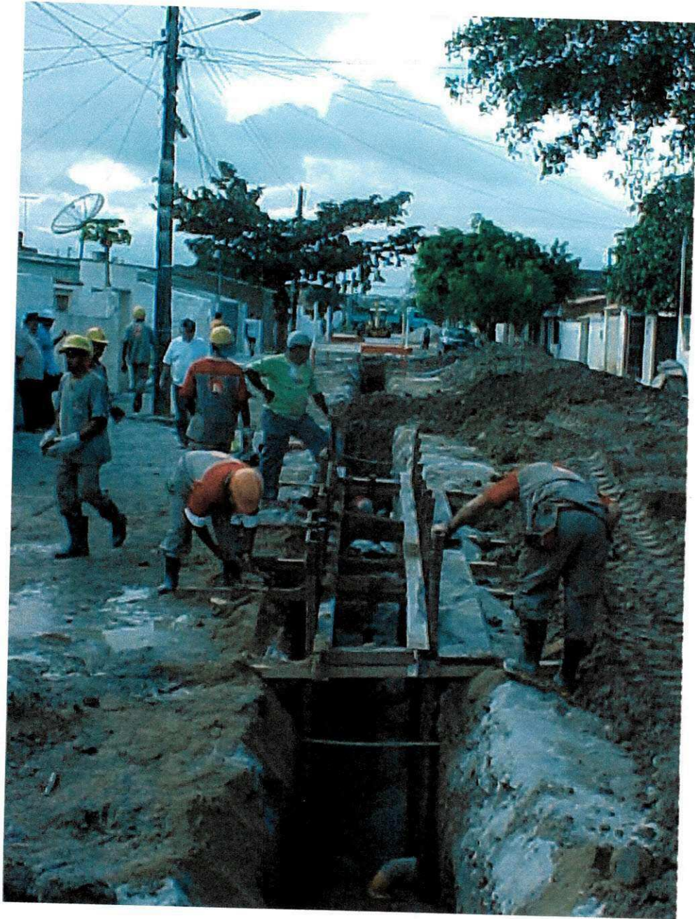
FIGURA 4 - Escoramento de valas
