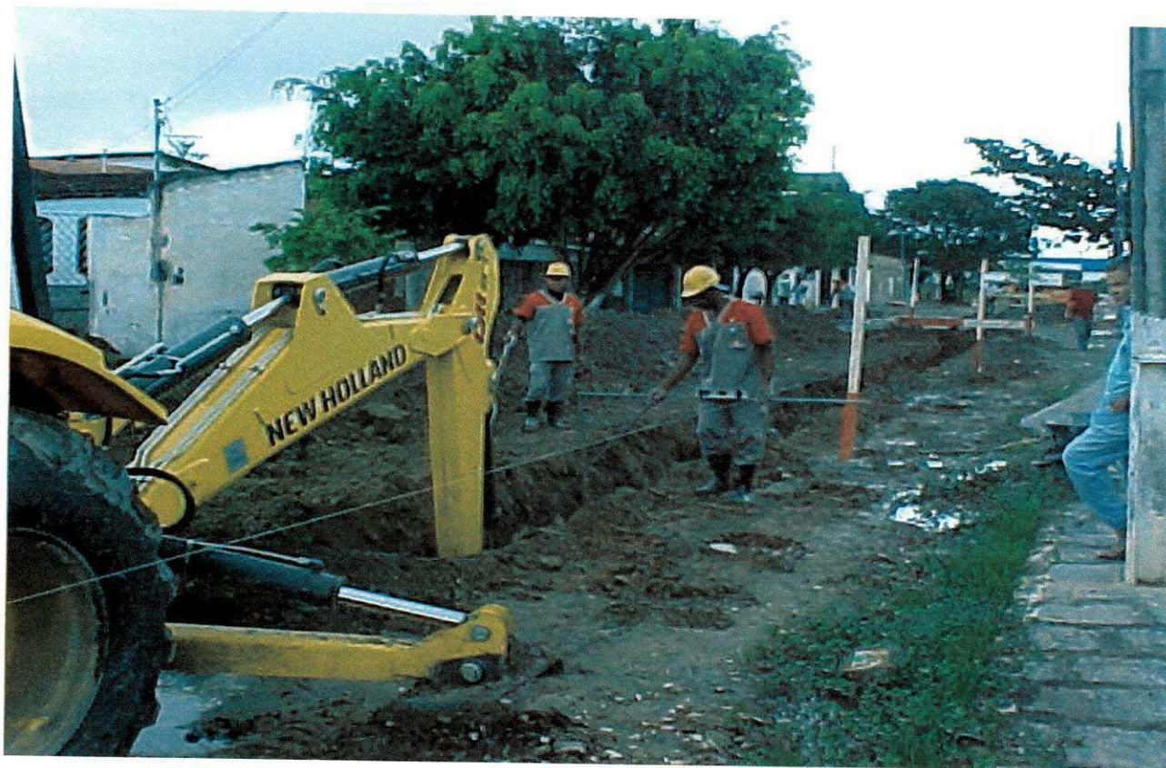
FIGURA 5 - Escavação mecânica de valas
