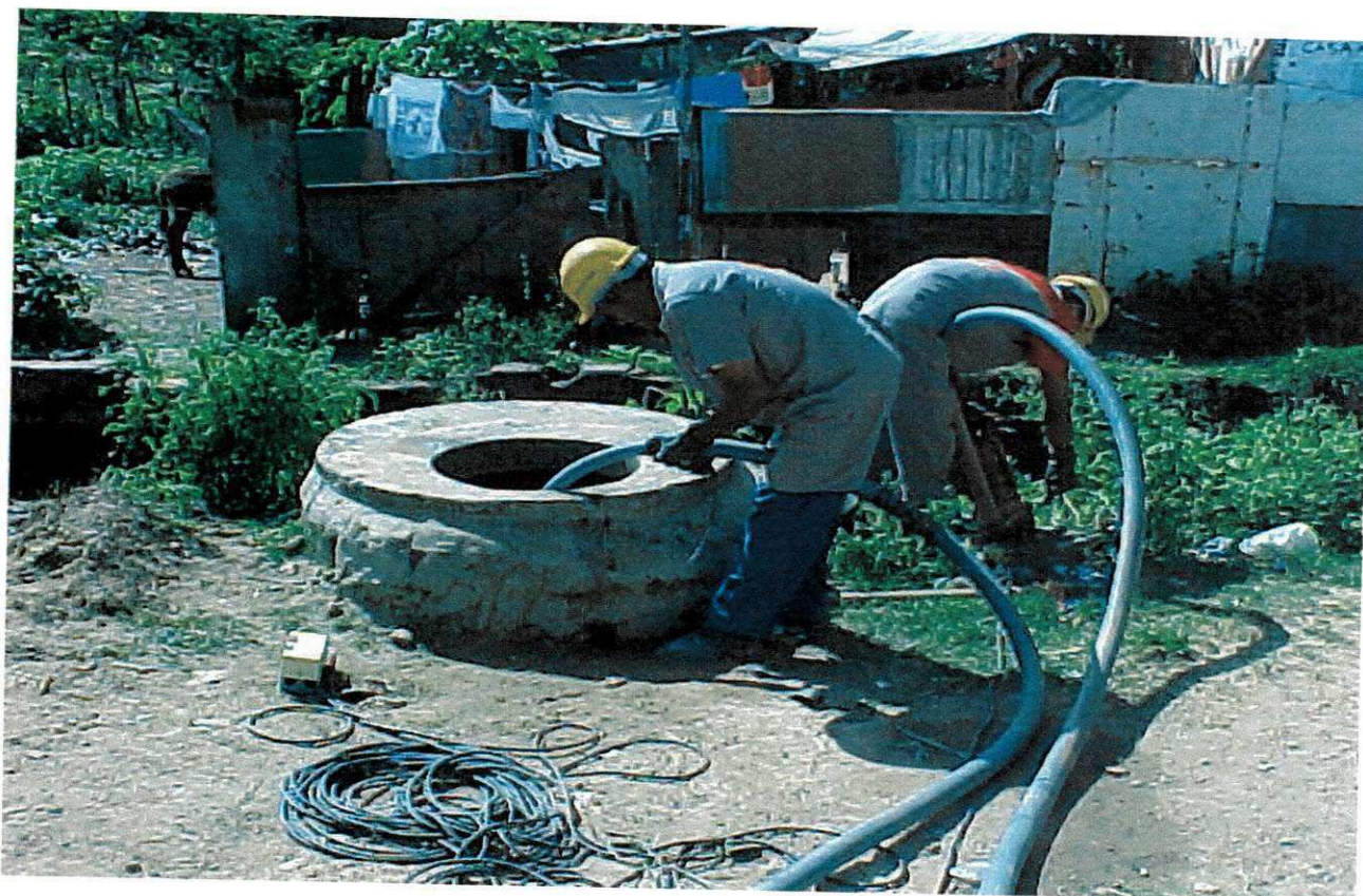
FIGURA 1- Desobstrução do PV
