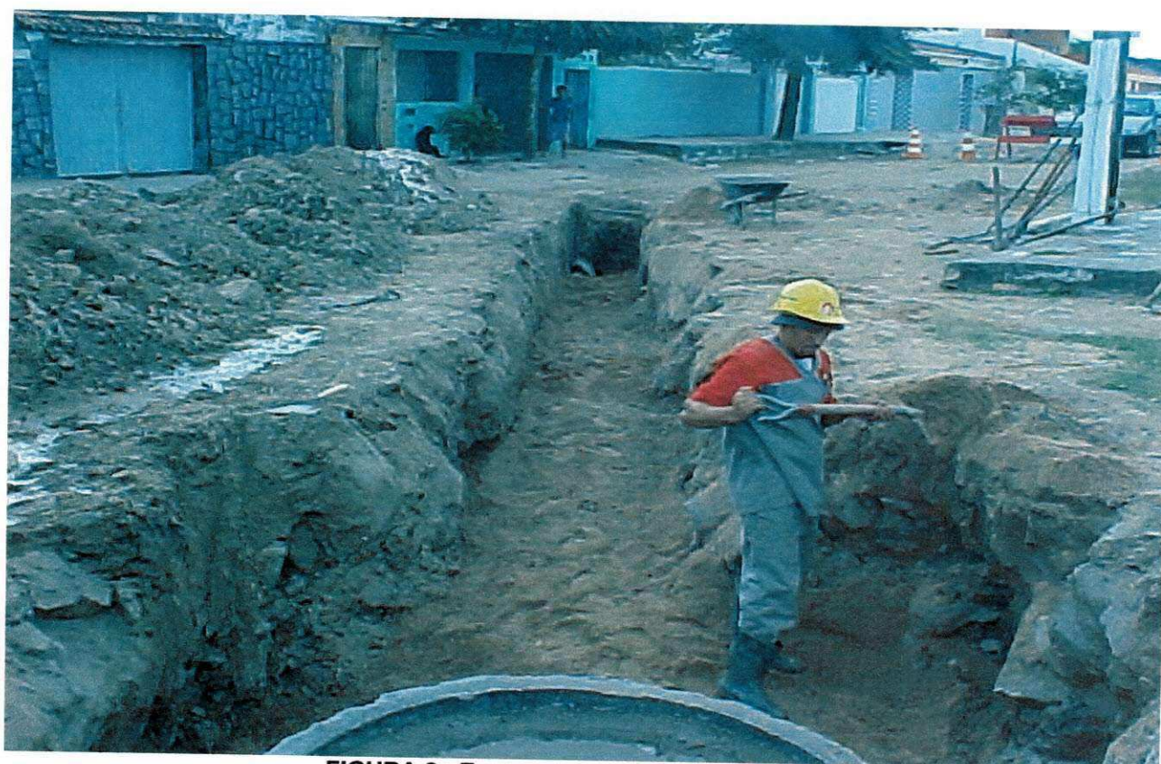
FIGURA 2 - Escavação manual de valas
