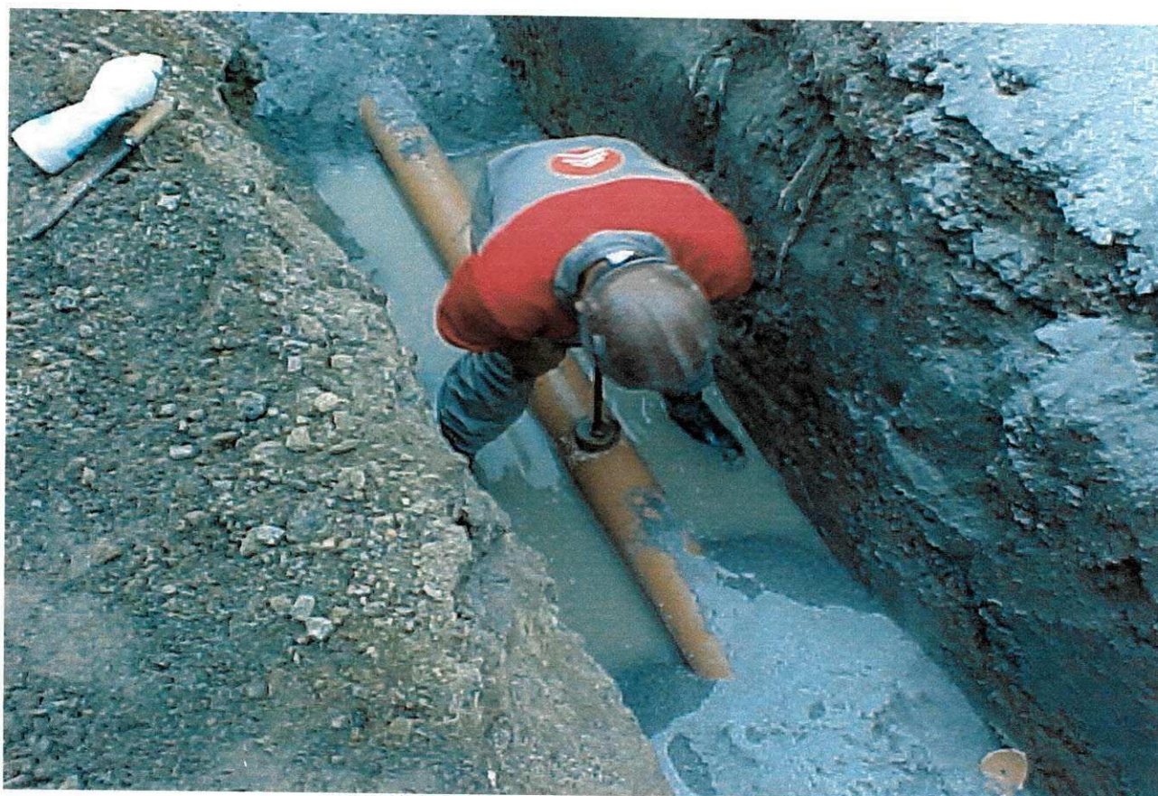
FIGURA 6 - Execução da rede de esgoto
