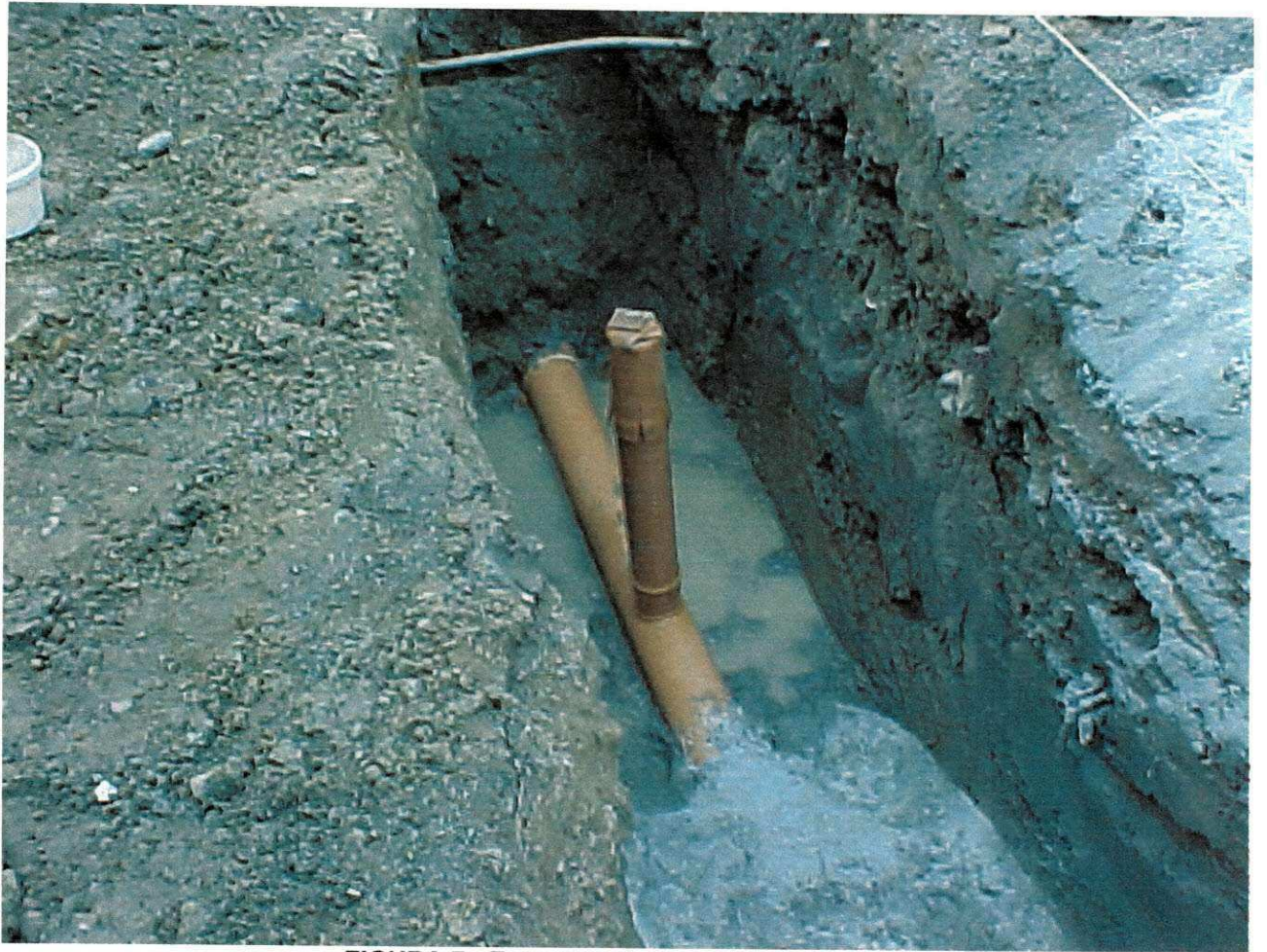
FIGURA 7 - Execução da rede de esgoto
