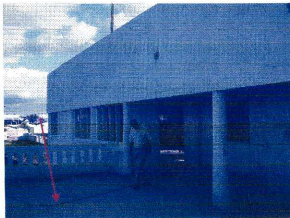
(32) – Laje maciça do museu
