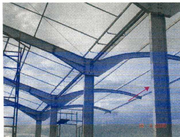
(37) – Perfis metálicos da estrutura do ginásio
