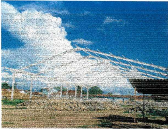
(38) – Estrutura metálica completa (ginásio)
