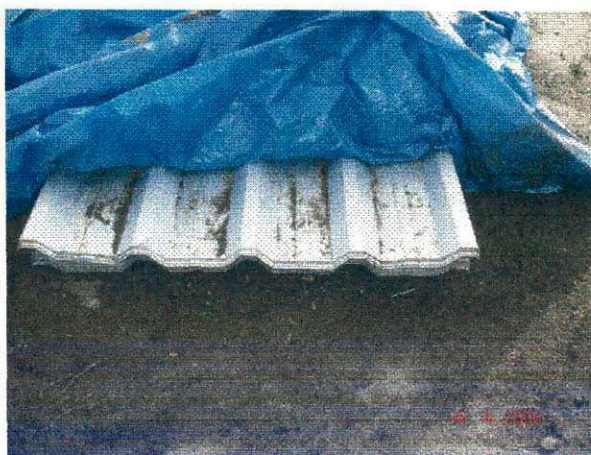
(44) – Telha metálica para cobertura do ginásio.
