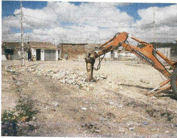
(5) – Demolição do muro (antes)
