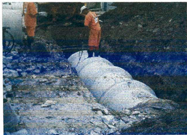
(46) – Instalação da tubulação
