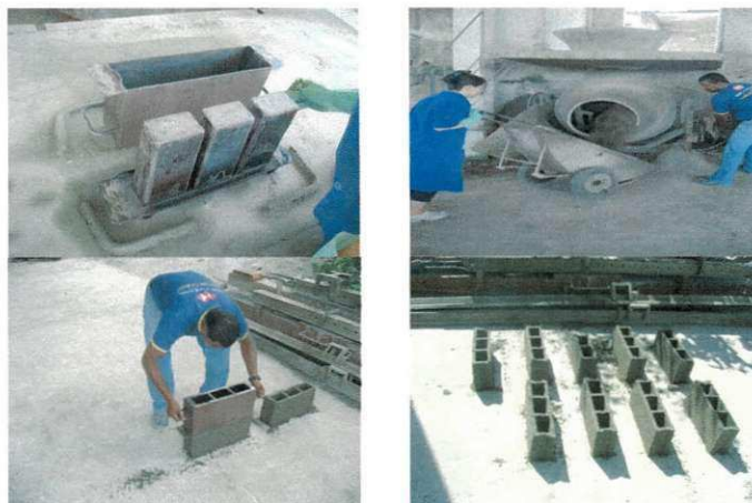
Figura 7 – Procedimentos para confecção dos blocos de concreto. Fonte: Direta (2007).
