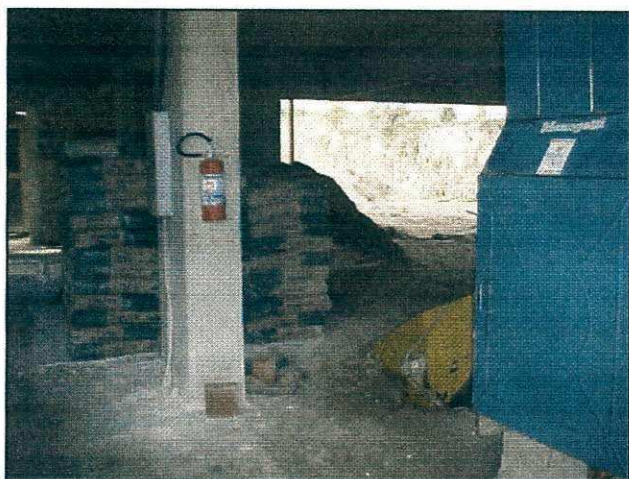
Materiais para confecção do concreto
