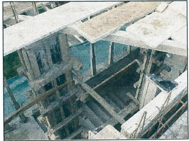
Concretagem da caixa de escadas
