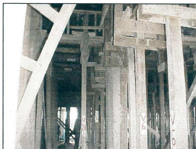
Formas e escoras – 17ª laje
