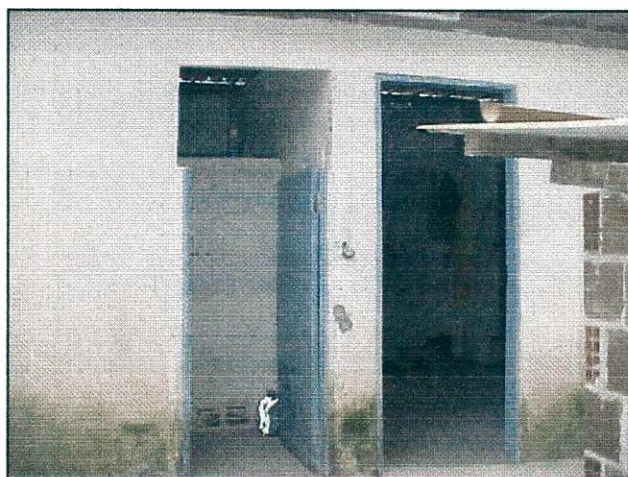
Alojamento e banheiro dos operários
