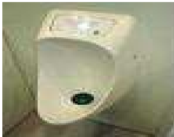
Figura 17. Mictório seco, o qual utiliza cartucho para coletar urina. Fonte: NETO e JÚLIO, 2014.
