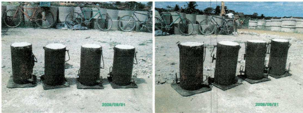
Figura 4 - Controle tecnológico do concreto
