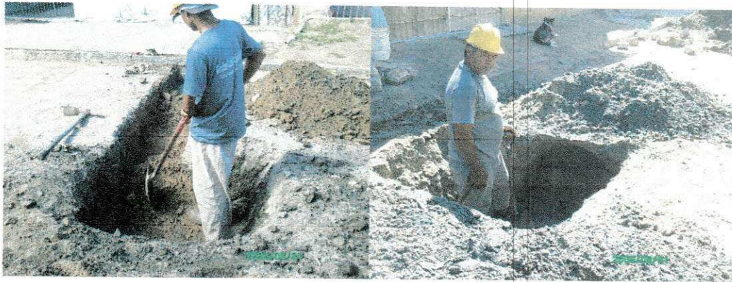
Figura 11 - Escavação em terra
