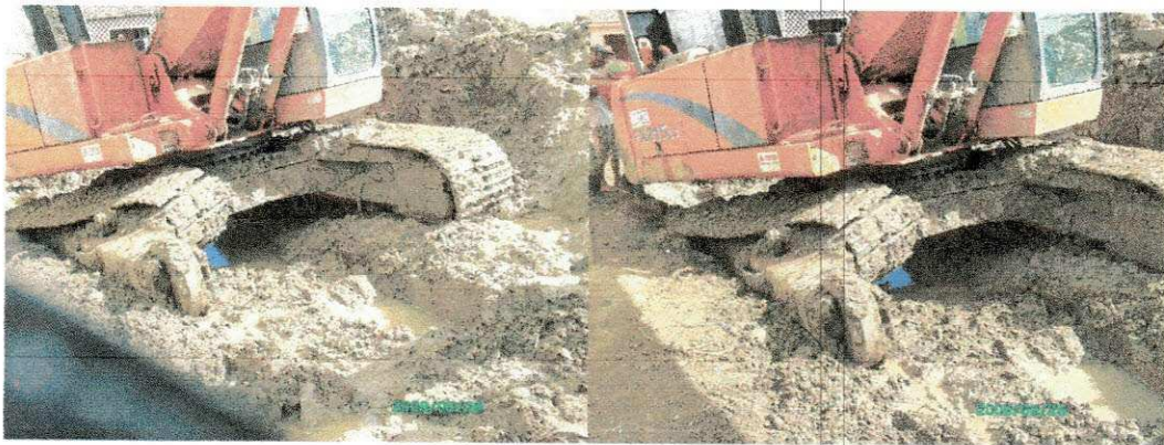
Figura 15 - Escavação em lama
