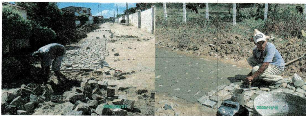
Figura 13 - Reposição de paralelepípedo
