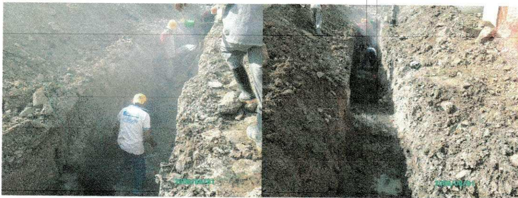
Figura 12 - Escavação em rocha dura
