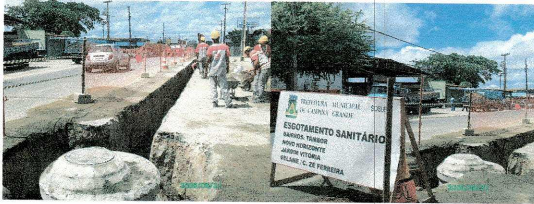
Figura 14 - Assentamento de PV
