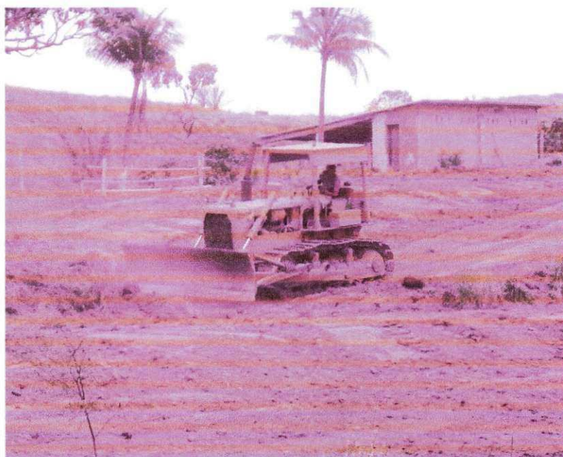
Figura 05 – Limpeza do terreno
