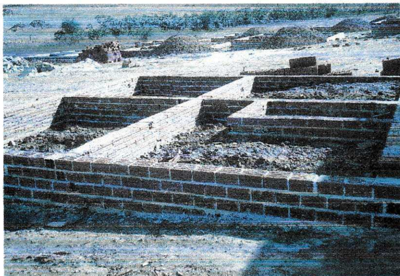
Figura 08 – Embassamento em alvenaria de uma vez
