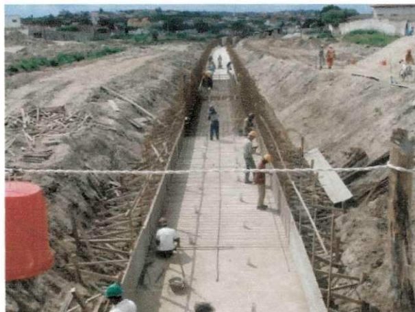
Figura 9 - Colocação da armadura no canal
