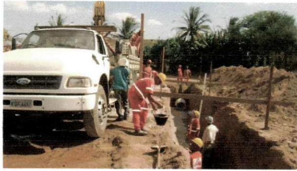
Figura 7 - Assentamento de tubos de concreto
