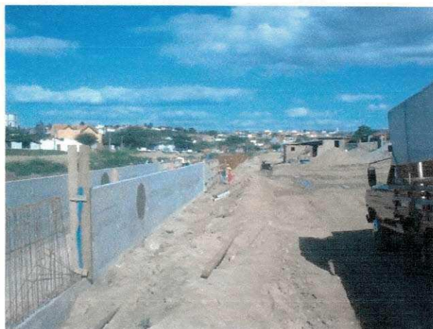
Figura 12 - Vista da lateral do canal
