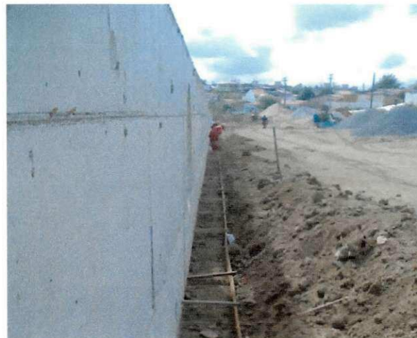
Figura 111 - Drenagem lateral do canal
