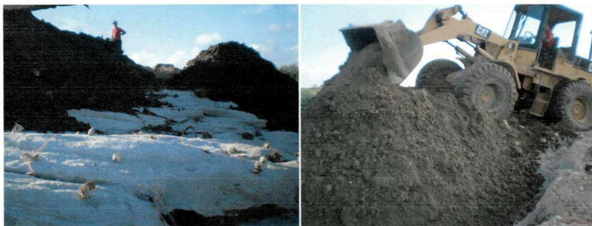
Figura 6 - Desmonte de rocha e abafamento
