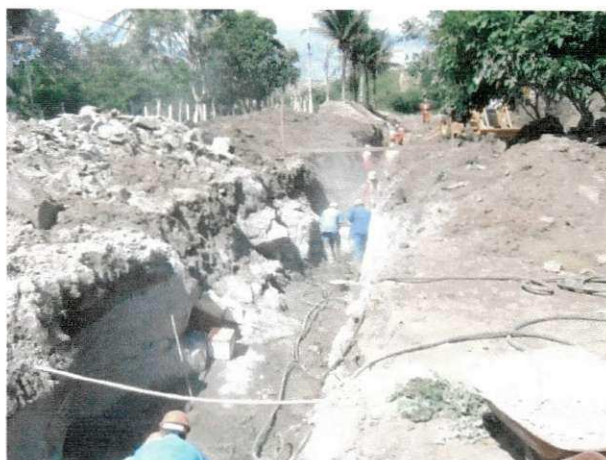
Figura 5 - Escavação de valas
