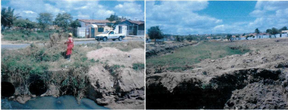
Figura 8 - Limpeza do terreno
