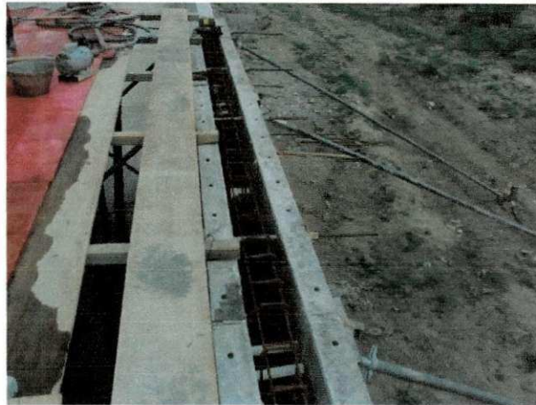
Figura 10 - Preparação das formas para concretagem
