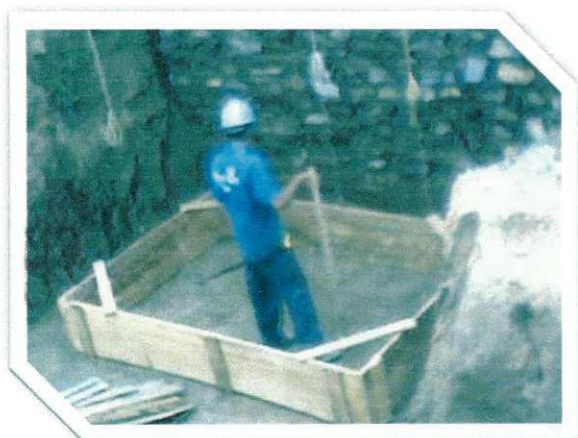
Figura 4 - Formas e armadura para sapatas
