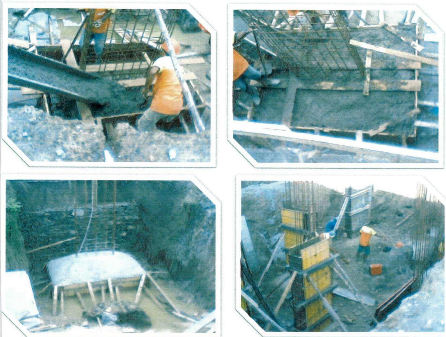
Figura 5 - Concretagem das sapatas e dos fustes
