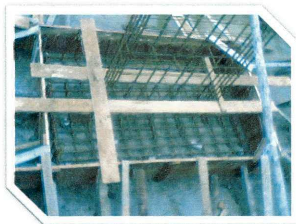
Figura 4 - Formas e armadura para sapatas
