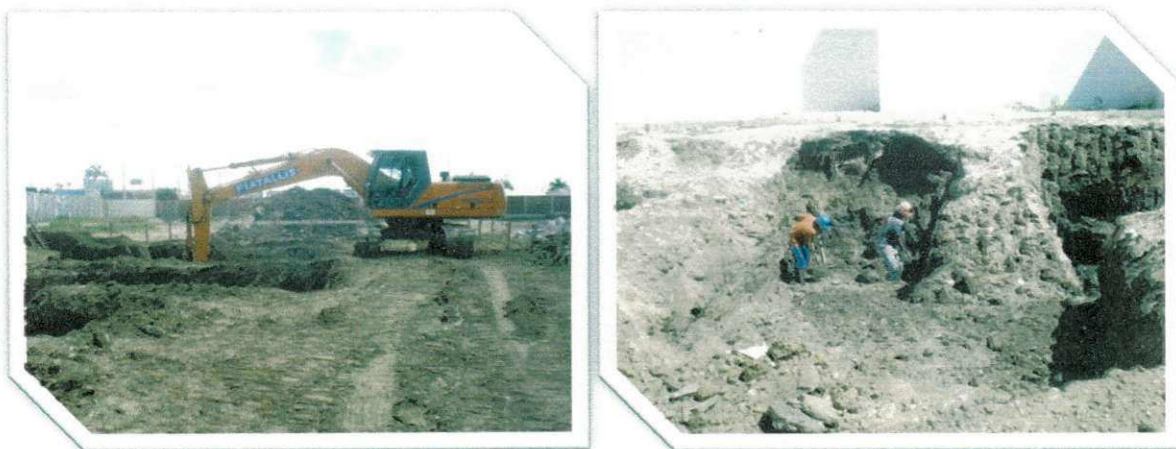
Figura 2 - Escavação mecânica e escavação manual
